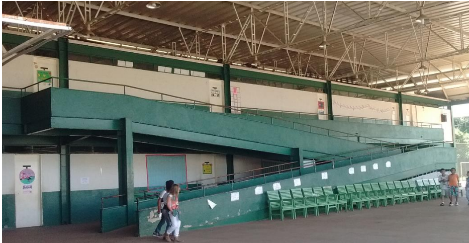
Figura 03: Pátio com rampa de acesso ao pavimento superior, estrutura em aço e cobertura em estrutura metálica.
