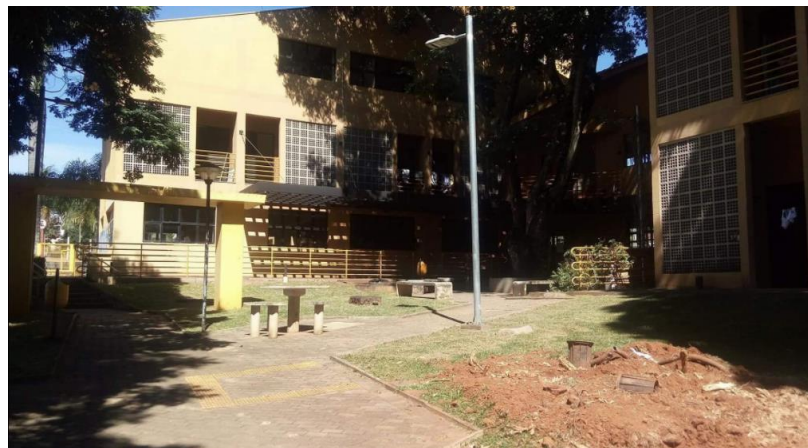
Figura 39 - Falta de manutenção da praça central
