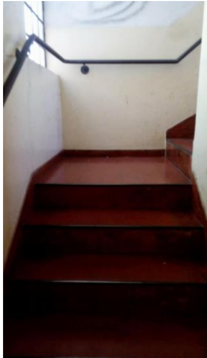
Figura 32 - Escada do pavimento térreo
