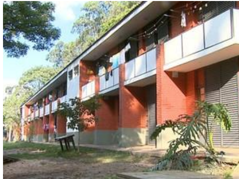
Figura30 - Fachada do Bloco A
