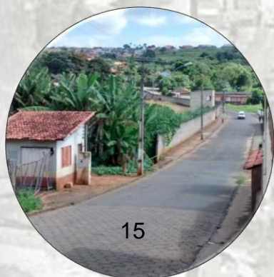
Vista 15 – Principal acesso ao bairro da Colina São Marcos, sem calçada
