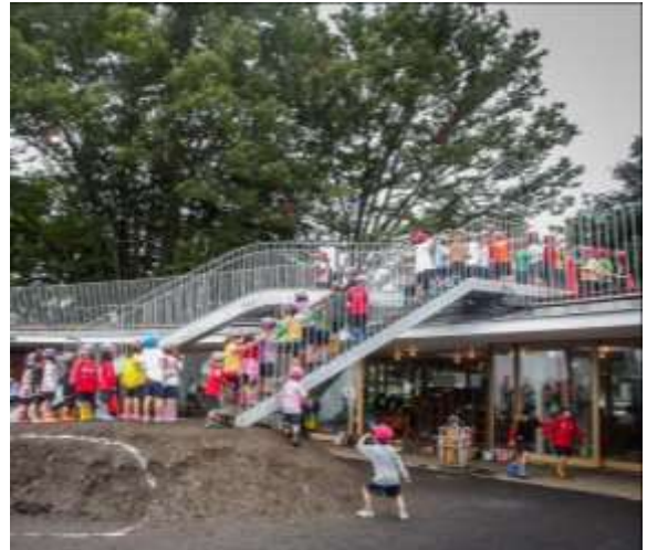
Figura 42- Saída de Emergência sendo usada no intervalo.
