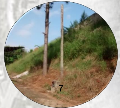
Vista 7 – Análise do desnível topográfico.
