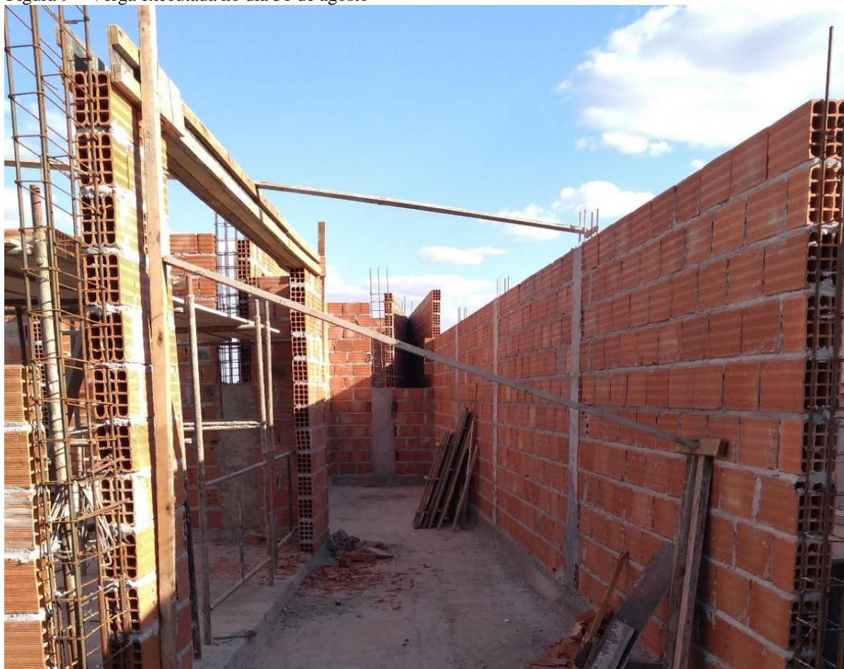
Figura 9 – Verga executada no dia 31 de agosto
