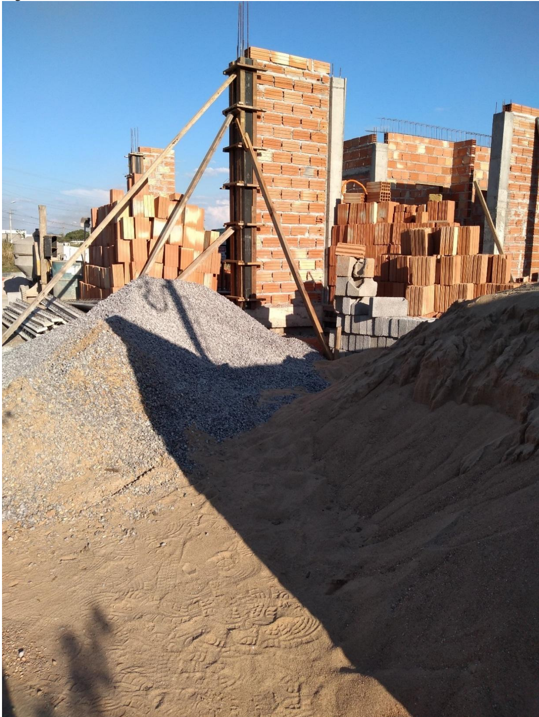
Figura 7 – Armazenamento de materiais
