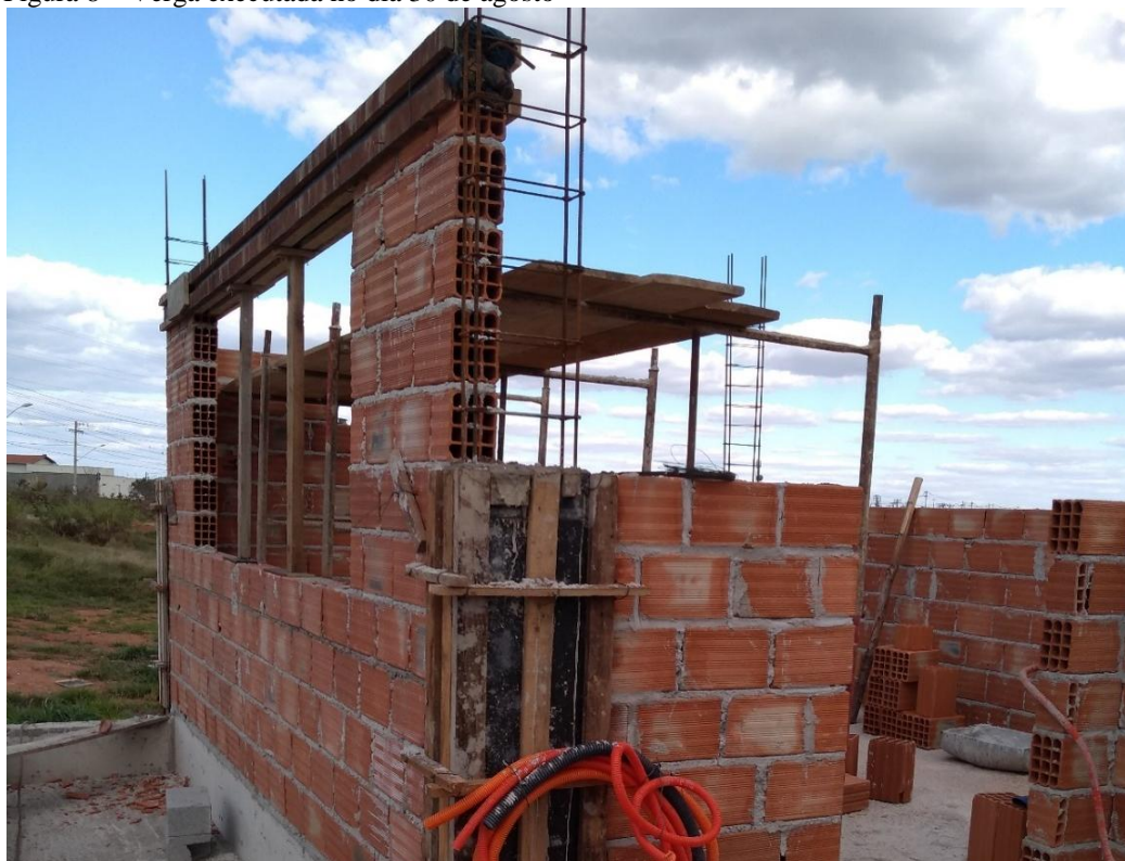
Figura 8 – Verga executada no dia 30 de agosto
