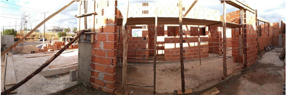
Figura 14 – Paredes da área de serviço no dia 04/09
