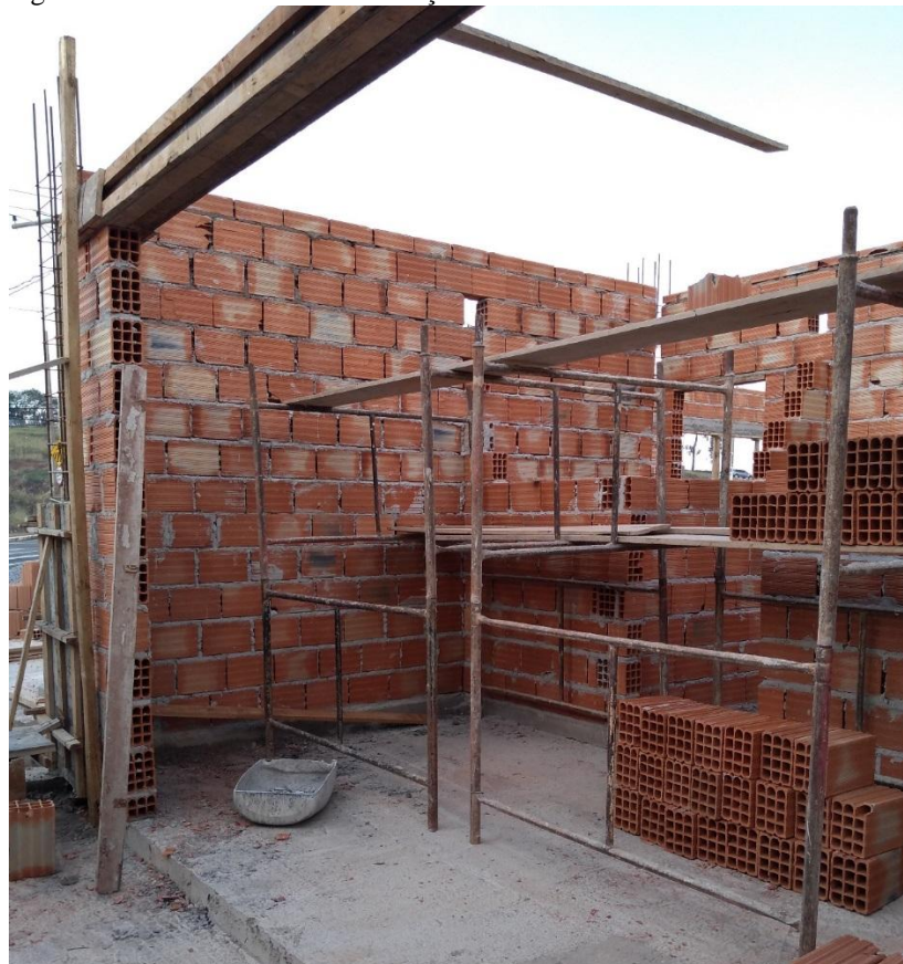
Figura 13– Paredes da área de serviço no dia 03/09
