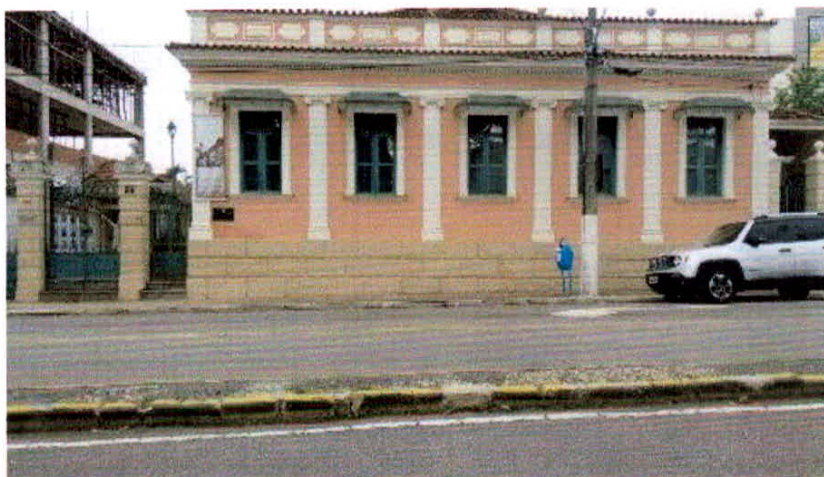
Figura 2 - Fachada Casa da Cultura. Fonte: A autora.
