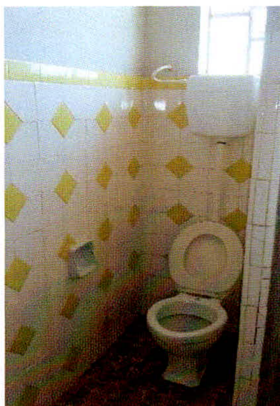
Figura 81 – Bacia sanitária sem barra de apoio. Fonte: a autora, 2015.
