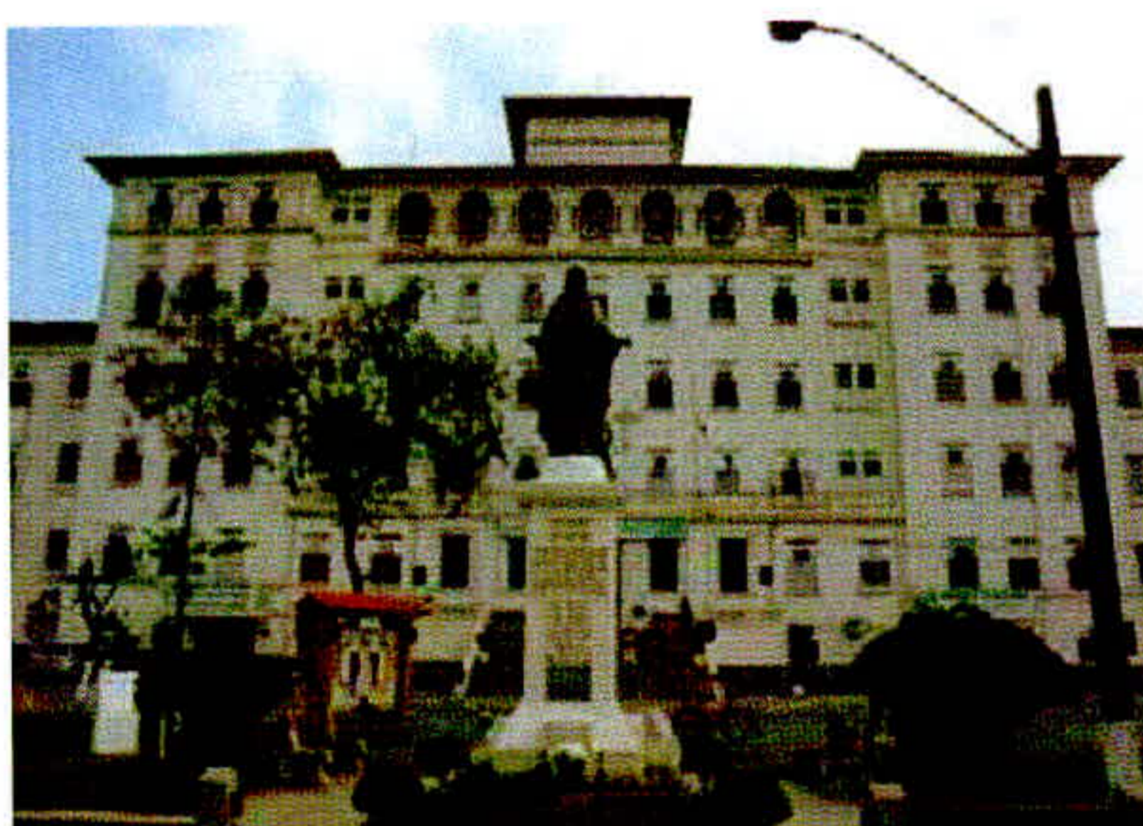
Figura 4 – Atual fachada do Hospital da Santa Cruz da Misericórdia de Santos. Fonte: www.sems.org.br
