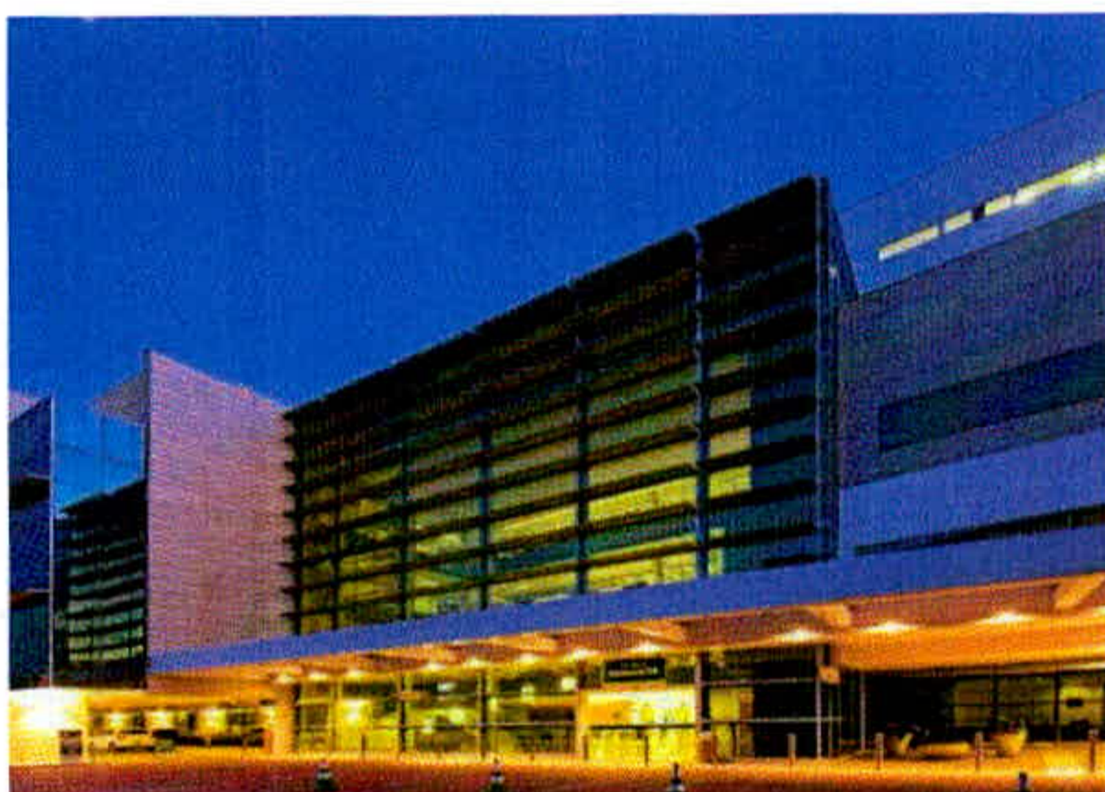
Figura 9 – Brises na fachada frontal. Fonte: http://arcoweb.com.br/projetodesign/arquitetura/raf-arquitetura-hospital-unimed-rio-janeiro . Acesso em: 18 de outubro de 2015.
