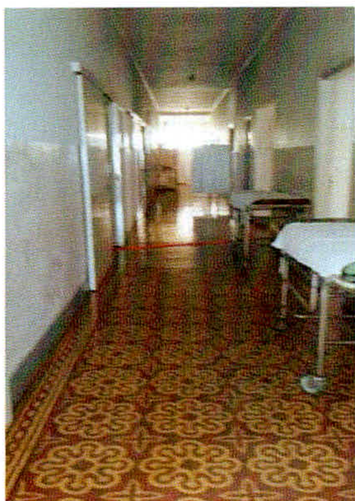
Figura 93 – Piso de ladrilho hidráulico. Fonte: a autora, 2015.
