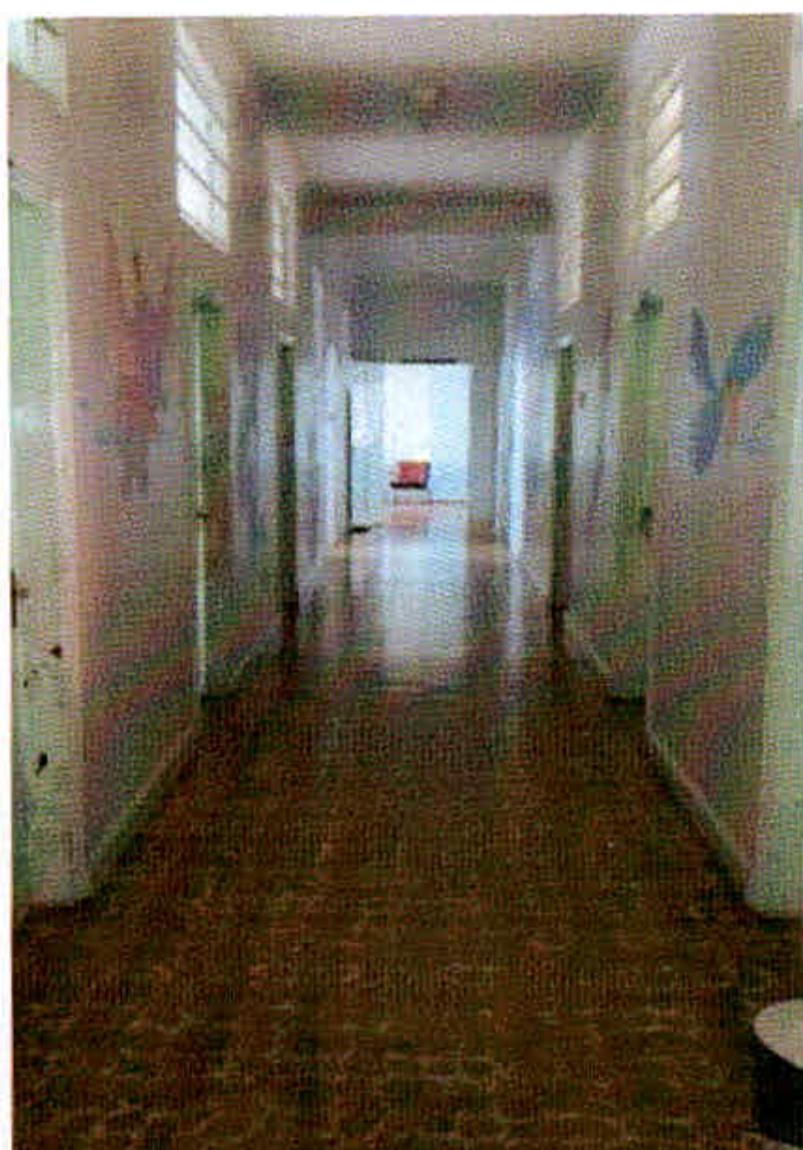
Figura 59 – Corredor da ala da pediatria, indicado pelo número 3 na figura 53, medindo 1,85 m de largura. Fonte: a autora, 2015.
