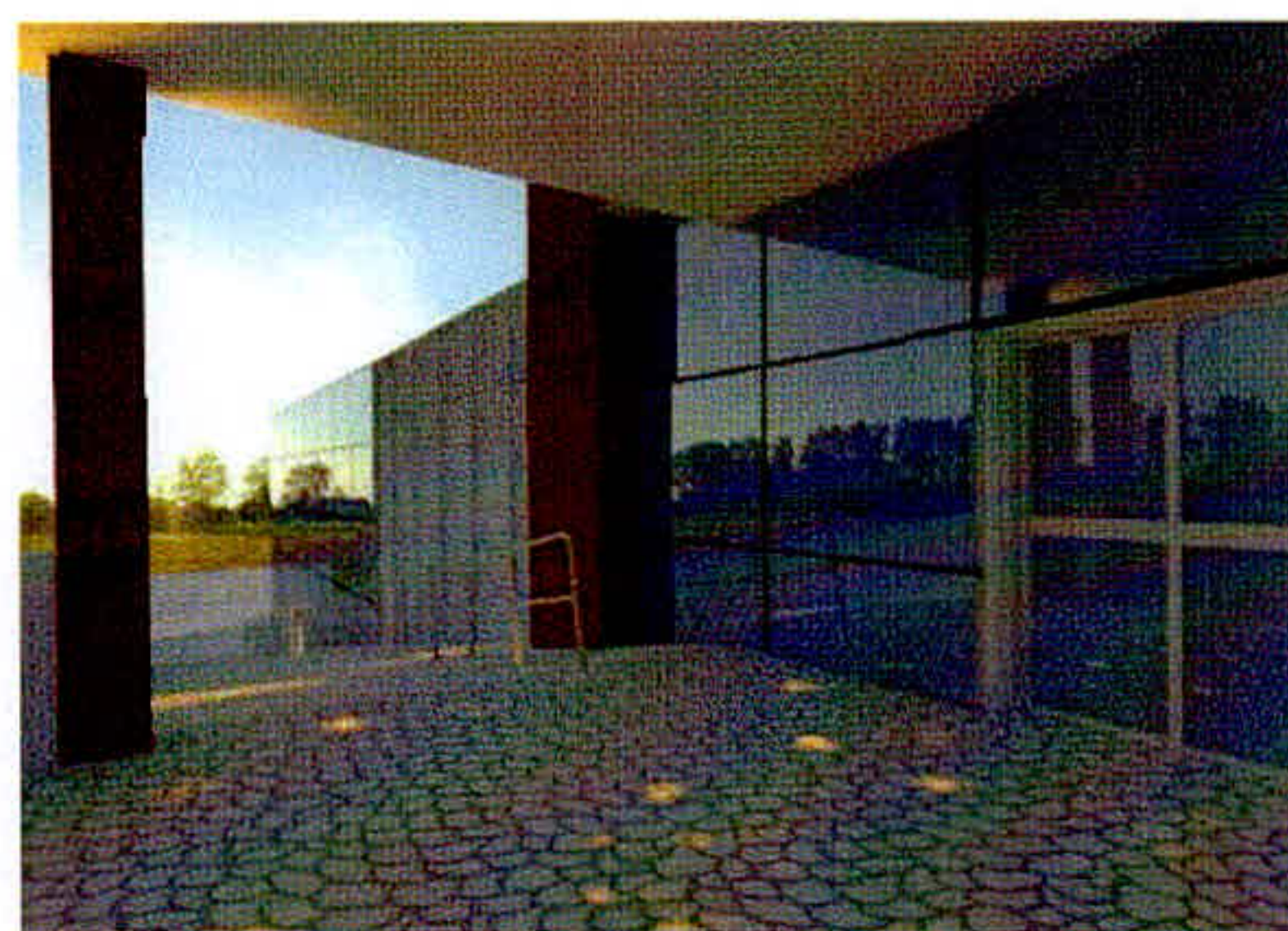
Figura 103 – Fachada com pele de vidro e brises de alumínio. Fonte: a autora, 2016.
