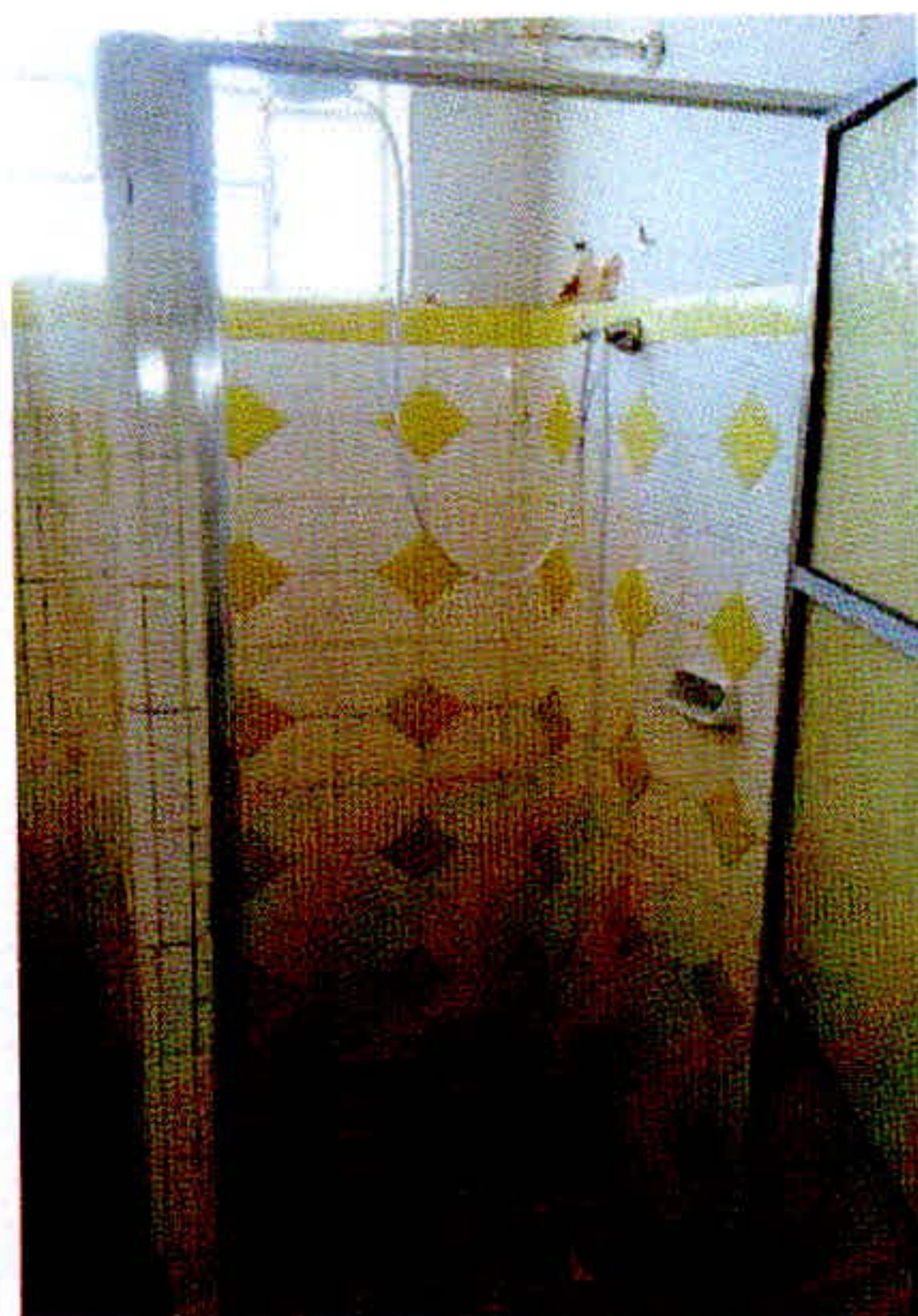
Figura 84 – Box de chuveiro sem barra de apoio. Fonte: a autora, 2015.
