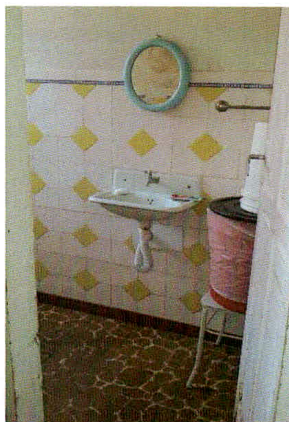
Figura 90 – Espelho em desacordo com a NBR 9050 (ABNT, 2015). Fonte: a autora, 2015.
