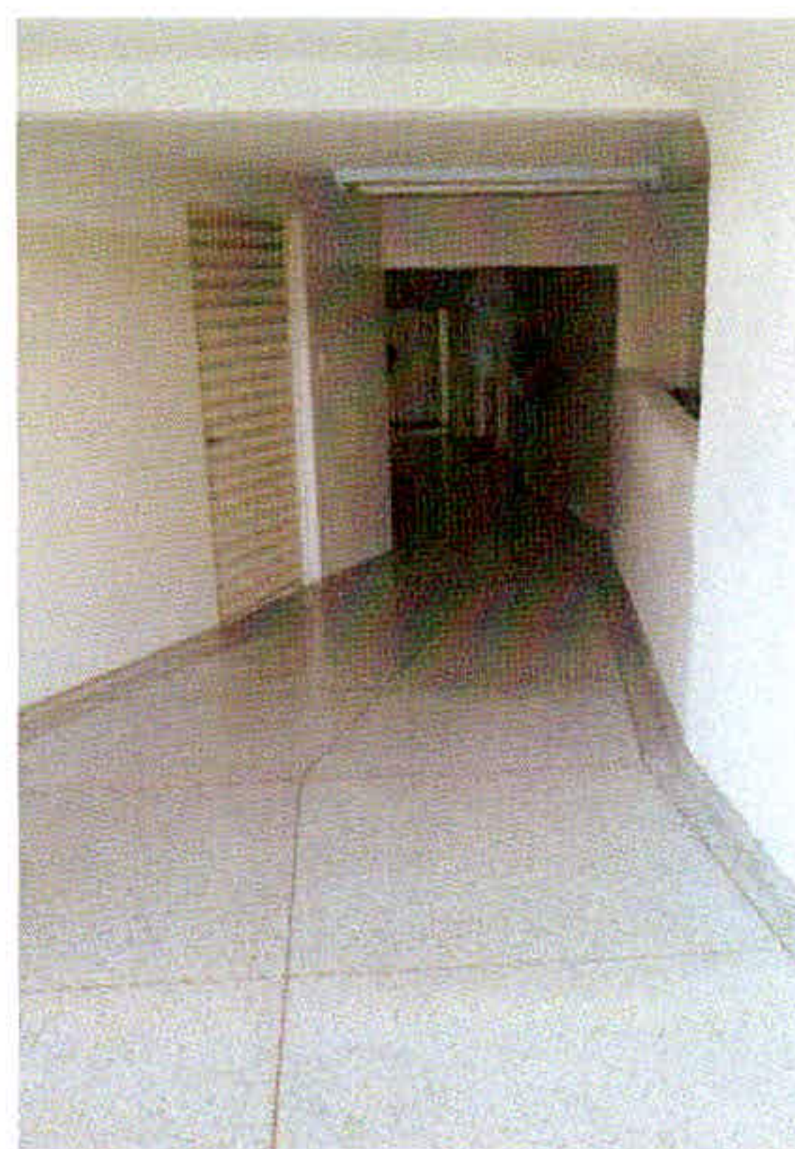
Figura 65 – 2º lance da rampa com dimensões que variam entre 1,08 m e 2,20 de largura. Fonte: a autora, 2015.
