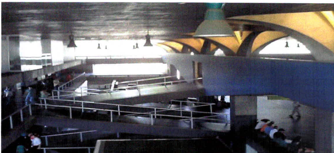
Figura 23 – Rampas de acesso interno.
