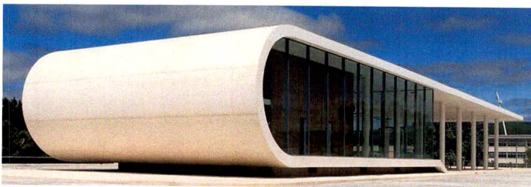
Figura 17 – Fachada Terminal Rodoviário Rio Maior.
