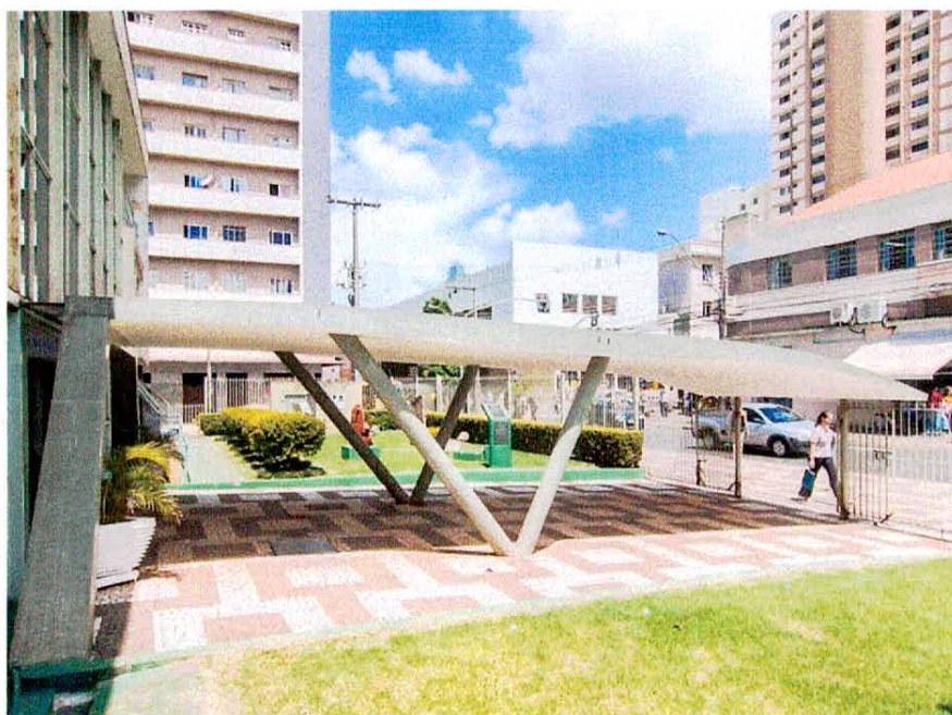
Figura 33 – Marquise que liga a rua com a rodoviária. Fonte: Fernando Stankuns. Acesso em: julho de 2016.
