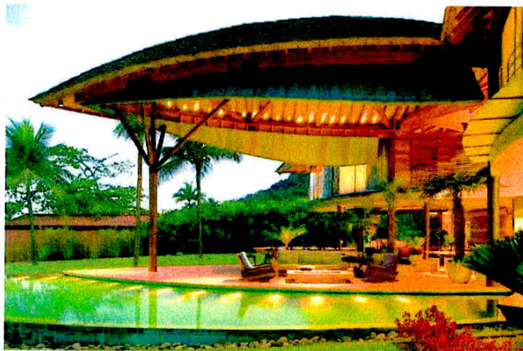
Figura 32. Detalhe cobertura - Casa Folha
