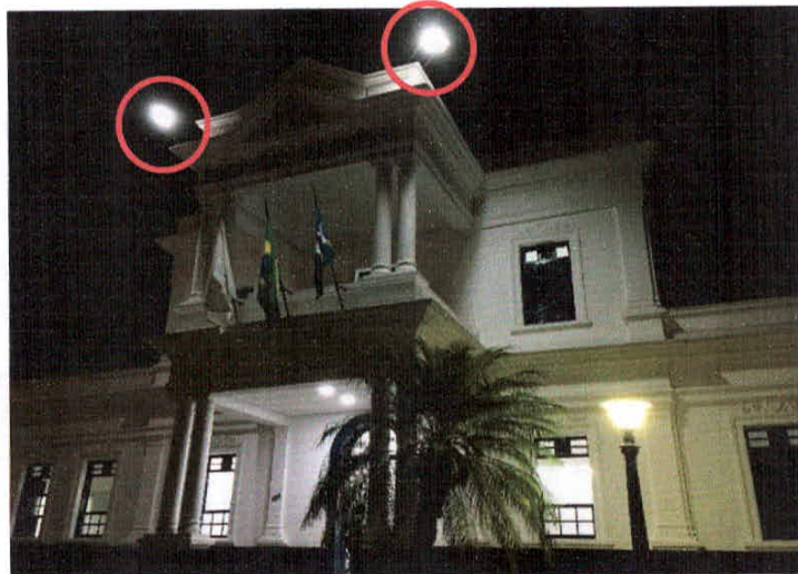
Figura 82. Projetores instalados acima do frontão central. Fonte: a autora, 2015.
