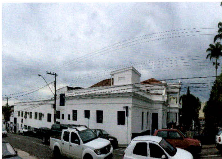
Figura 68. Fachada lateral do Hospital Regional do Sul de Minas. Fonte: a autora, 2015.
