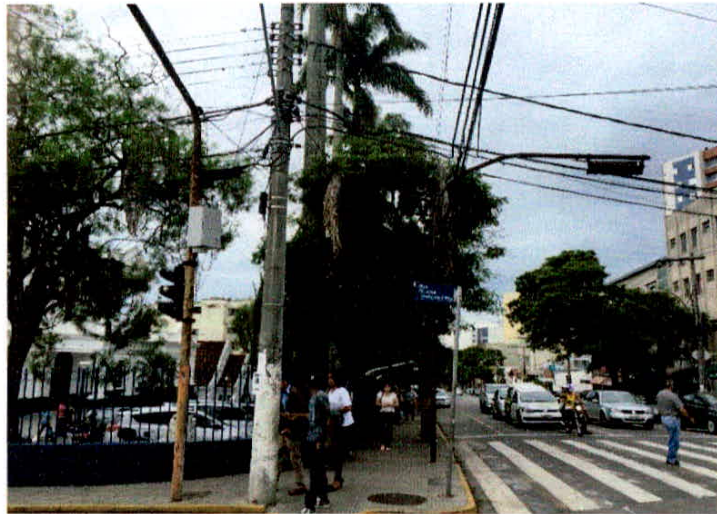
Figura 71. A fachada principal do Hospital se dá para a Avenida Rui Barbosa
