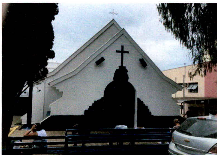
Figura 69. Fachada da Capela Nossa Senhora das Graças. Fonte: a autora, 2015.
