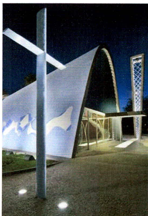
Figura 64. Fachada frontal com destaque para a iluminação da cruz, marquise e campanário. Fonte: www.arcoweb.com.br . Acessado em 06/11/2015.
