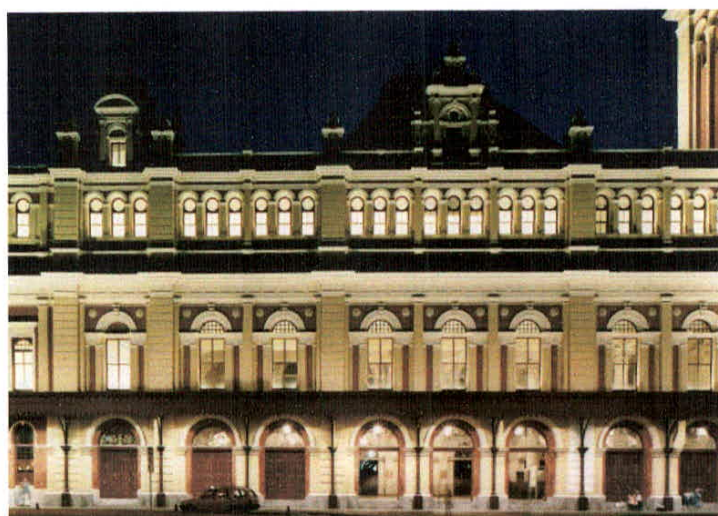
Figura 52. Fachada iluminada da Estação da Luz Fonte: Gilberto Franco Associados. Foto/Andrés Otero
