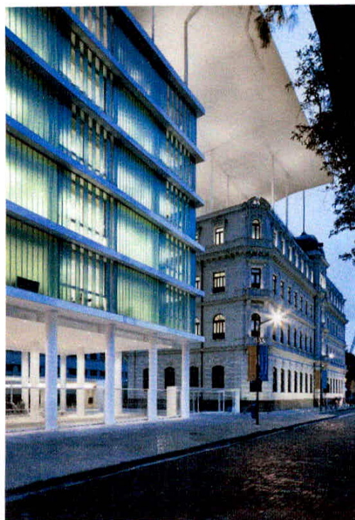
Figura 34. Cobertura fluída interligando os dois edifícios.
