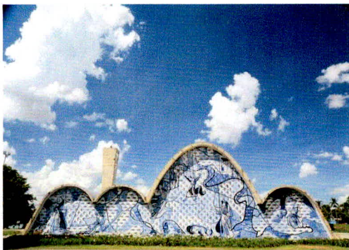
Figura 60. Fachada posterior da Igrejinha da Pampulha. Fonte: www.flickr.com . Acessado em 06/11/2015.
