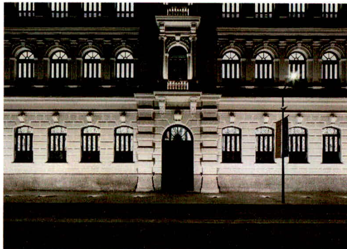
Figura 39. Fachada iluminada por projetores de fecho assimétrico. Fonte: Franco + Fortes - Lighting Design. Foto/Andrés Otero
