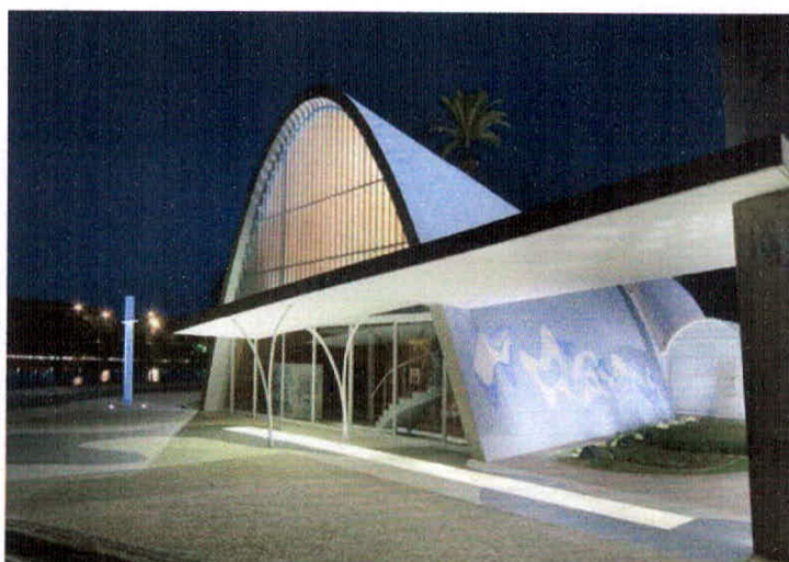
Figura 62. Fachada frontal com destaque para a obra de Paulo Werneck Fonte: www.arcoweb.com.br . Acessado em 06/11/2015.
