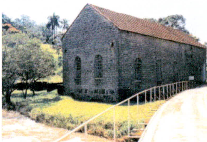
Figura 27. Casa de Pedra. Fonte: CODEPAC, 2013
