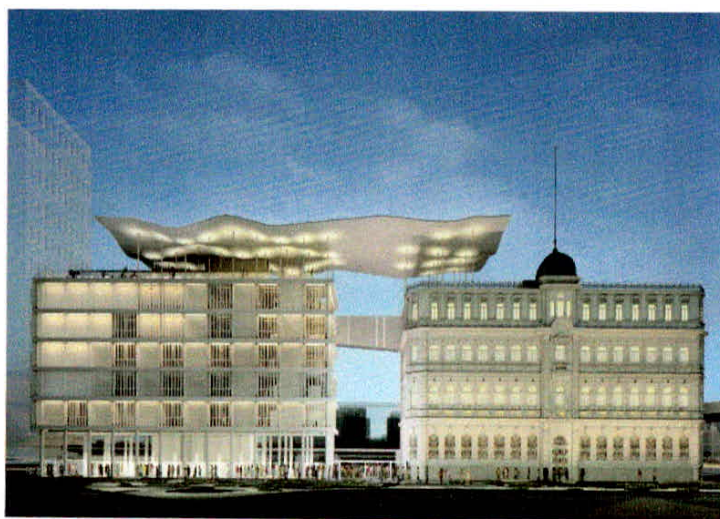
Figura 29. Museu de Arte do Rio Fonte: Franco + Fortes - Lighting Design. Foto/Andrés Otero
