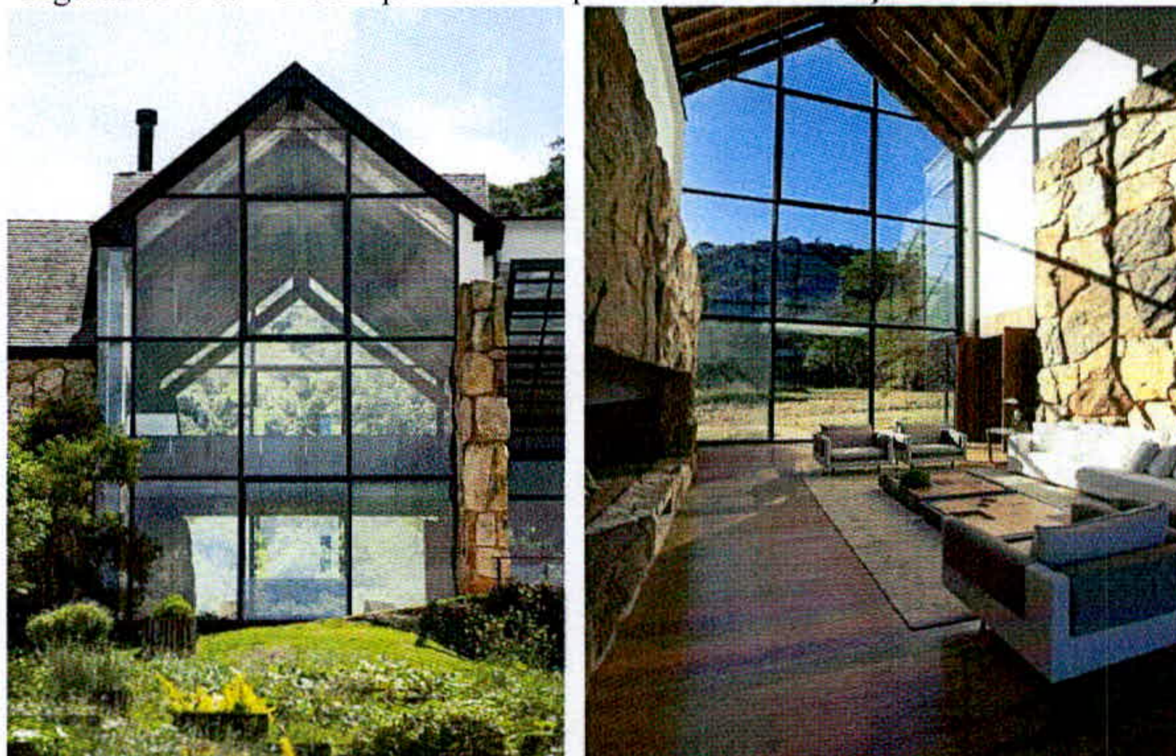
Figuras 06 e 07 – Botanique Hotel &amp; Spa – fachada envidraçada externa e interna
