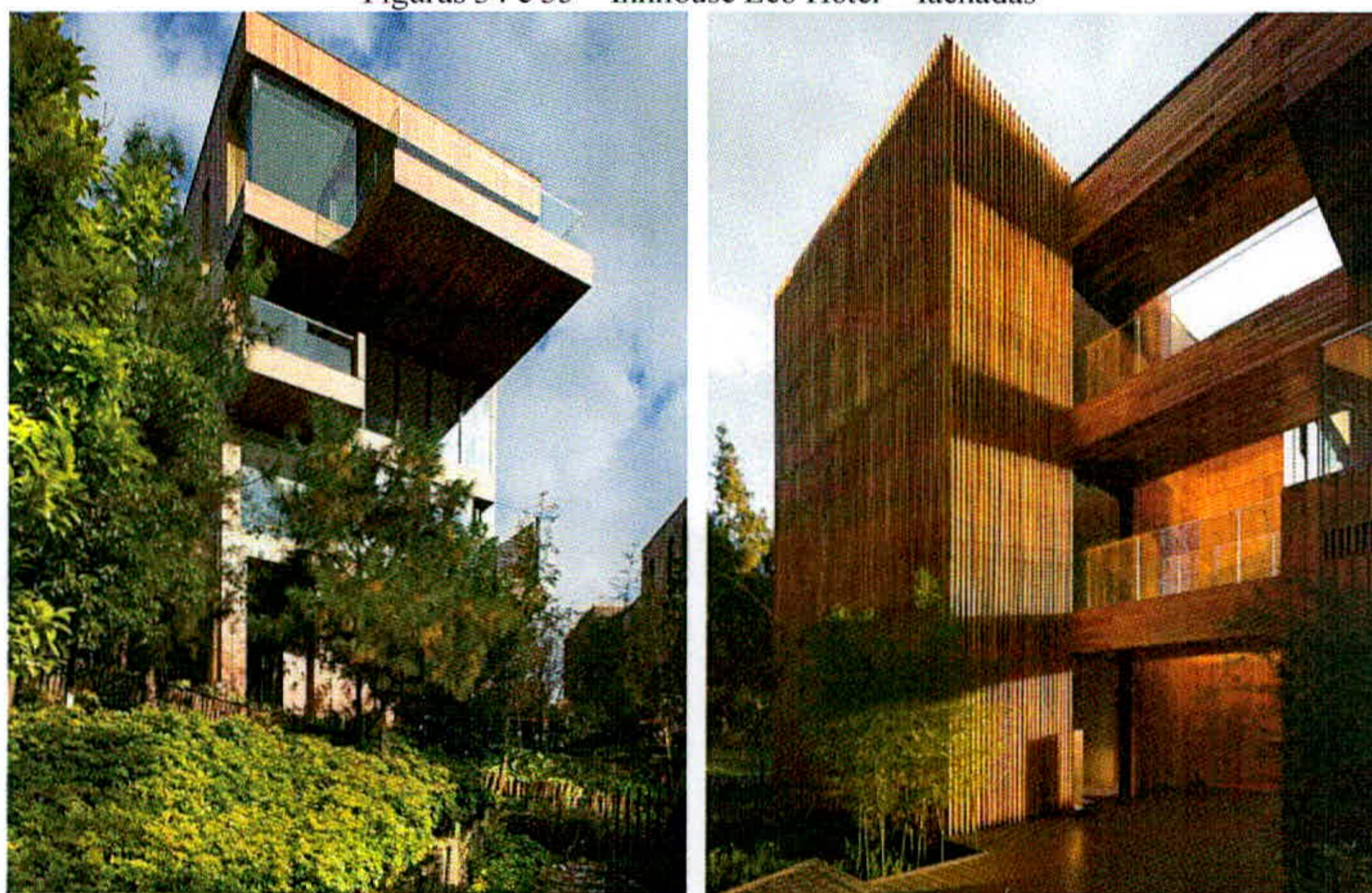
Figuras 34 e 35 – Innhouse Eco Hotel – fachadas
