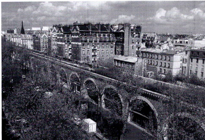
Figura 9 – Viaduto Coulée Verte
