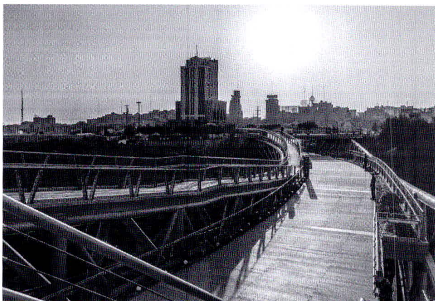
Figura 14 – Vista interior da passarela de pedestres Tabiat
