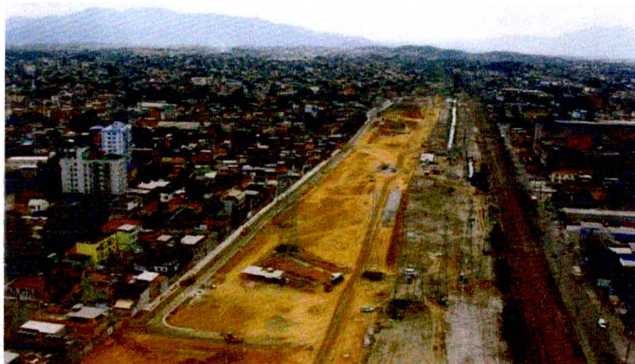
Figura 36 - Parque de Madureira em processo de construção;
