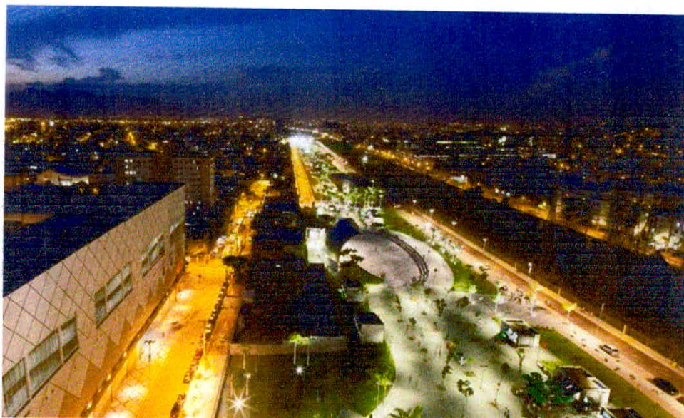
Figura 37 - Vista geral do parque de Madureira, executado;
