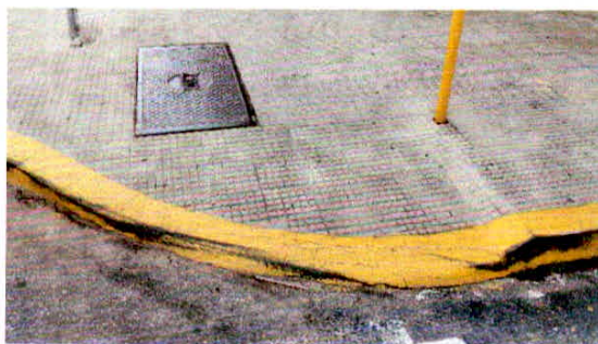
Figura 91 – Rampa de acesso a calçada – Avenida Rio Branco.
