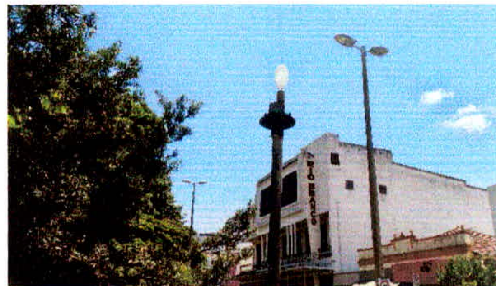
Figura 77 – Poste de iluminação indireta sem lâmpada.
