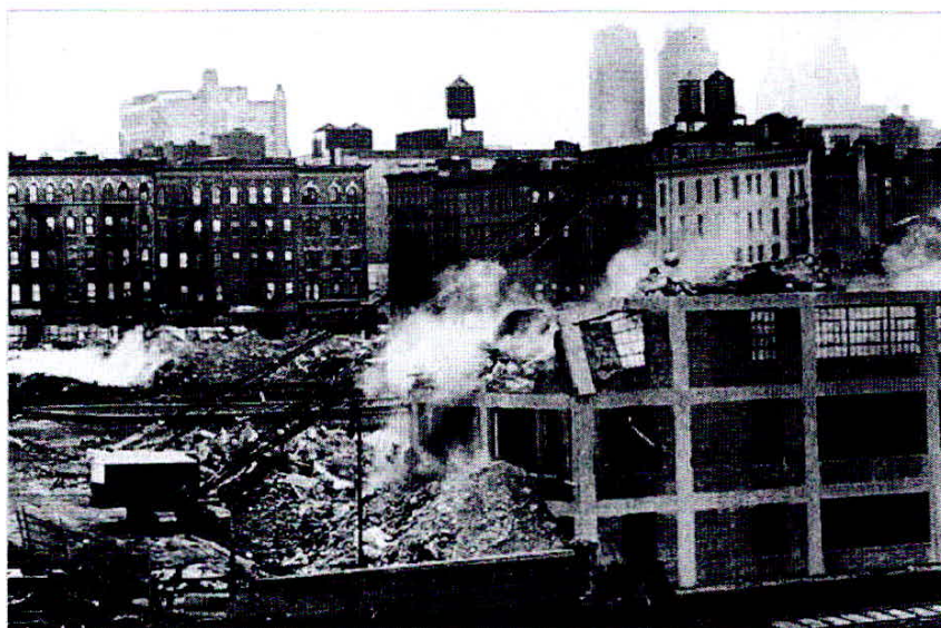
Figura 7 – Demolição no bairro San Juan Hill para construção do Lincoln Center em 1959 – Nova York, Estados Unidos.
