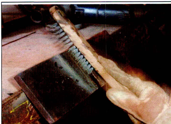
Figura 3.17 – Limpeza com escova manual de aço entre passes.
