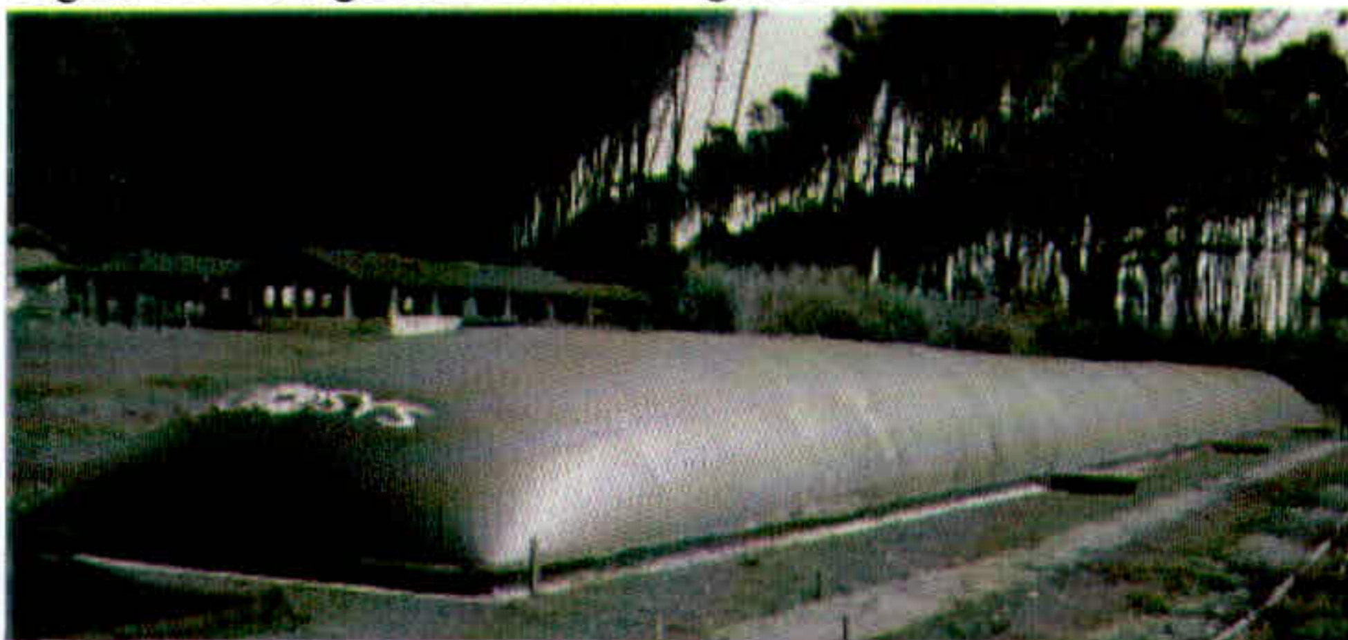
Figura 11: Biodigestor inflado com gases.
