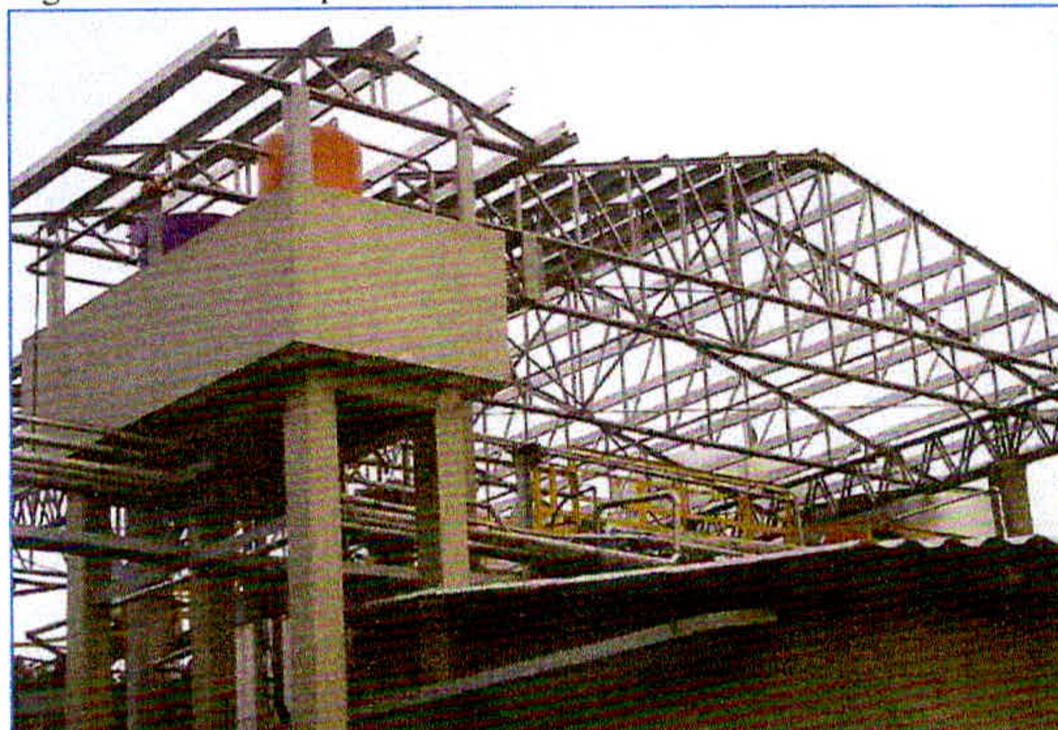
Figura 14 – Estrutura para coberturas
