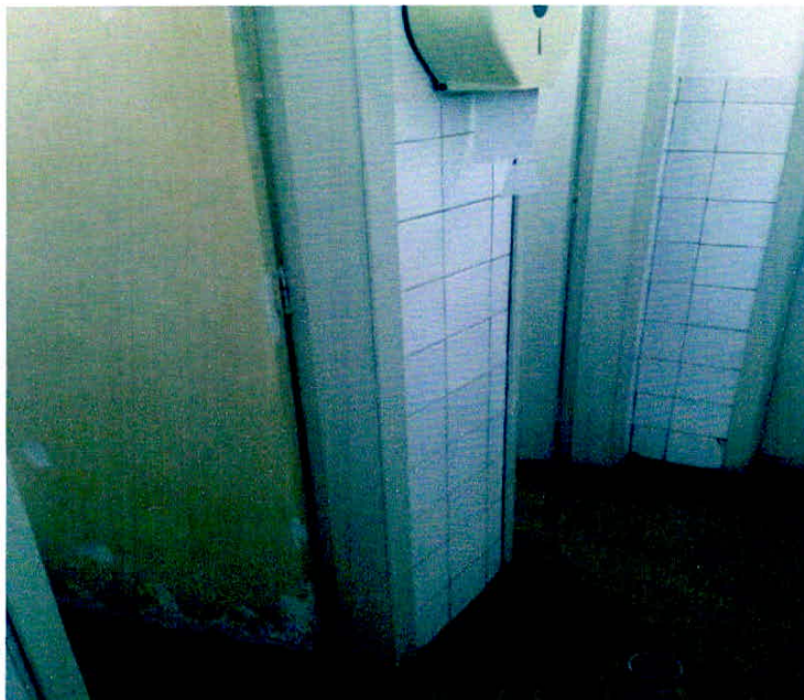
Figura 26: Porta dos banheiros
