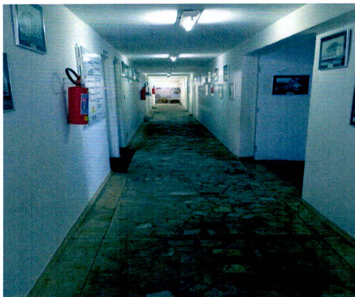
Figura 31: Área de circulação interna
