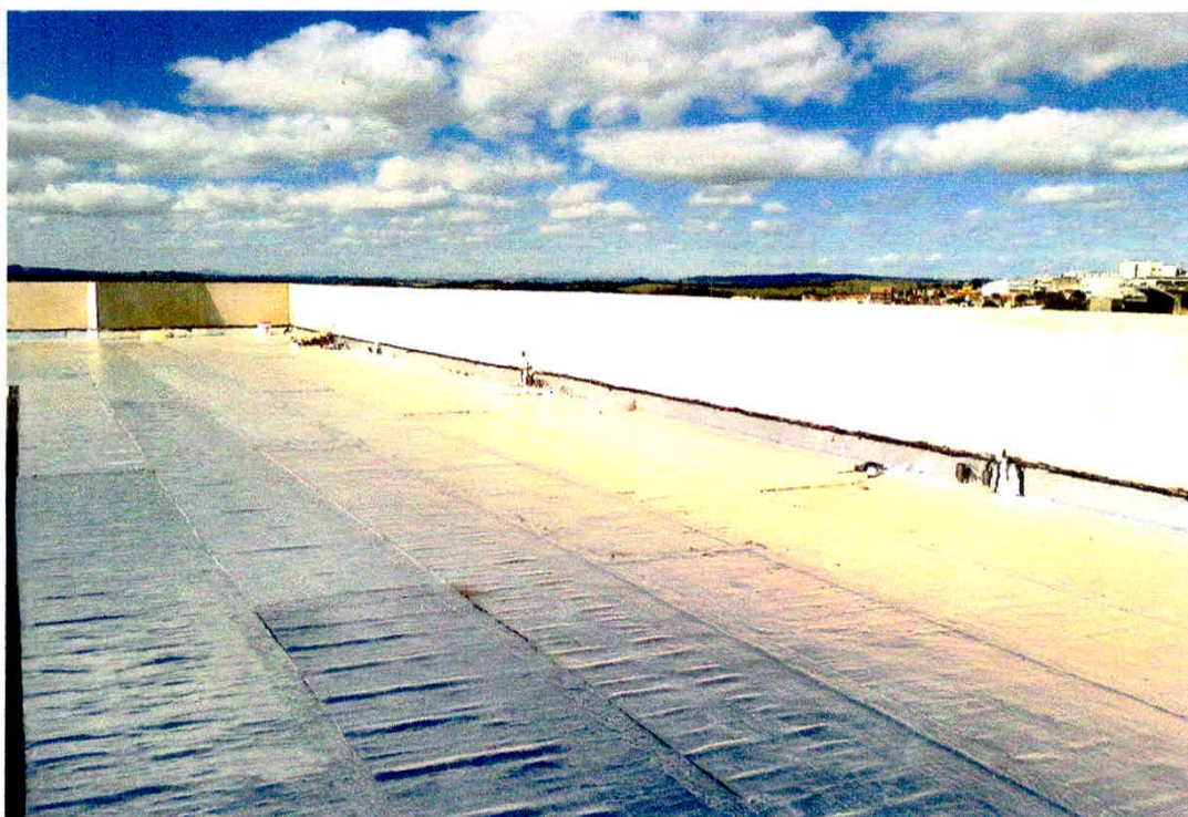
Figura 23 – Manta Asfáltica Aplicada
