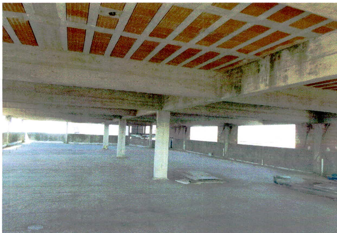
Figura 3 - Face Inferior da Laje de Cobertura
