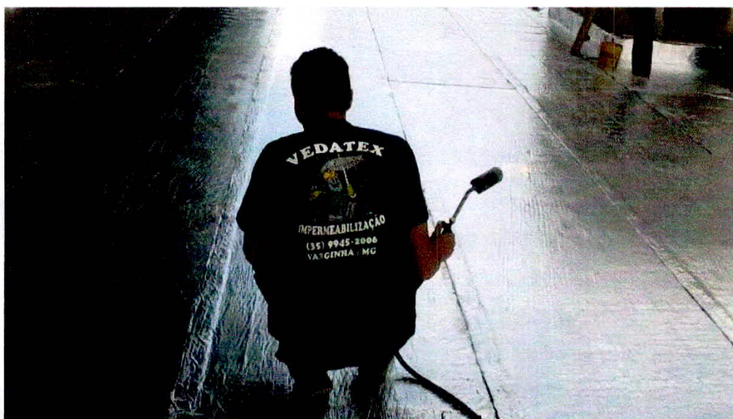
Figura 22 – Aplicação da Manta Asfáltica com Maçarico
