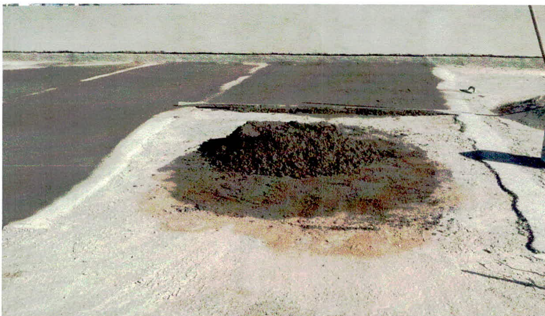
Figura 13 – Regularização Traço Volumétrico (1:3)
