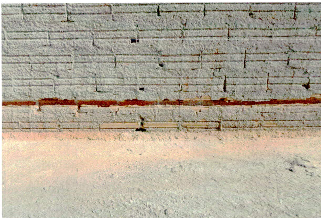
Figura 10 – Platibandas Chapiscadas
