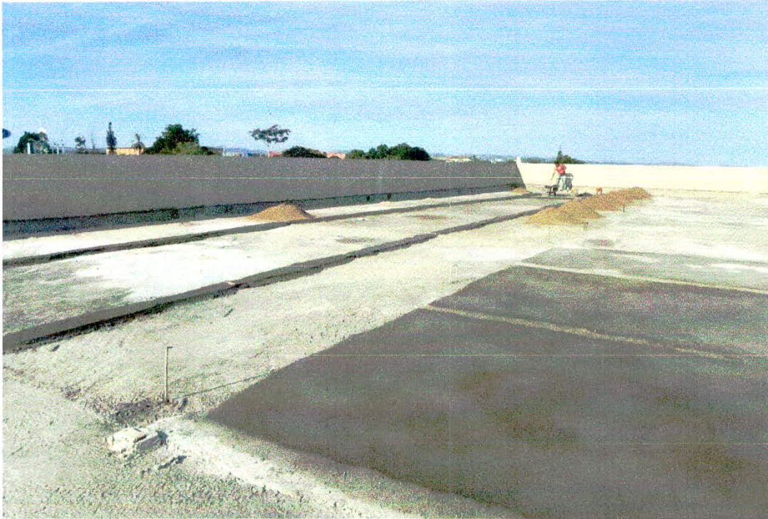
Figura 14 – Regularização da Laje e Platibandas Rebocadas
