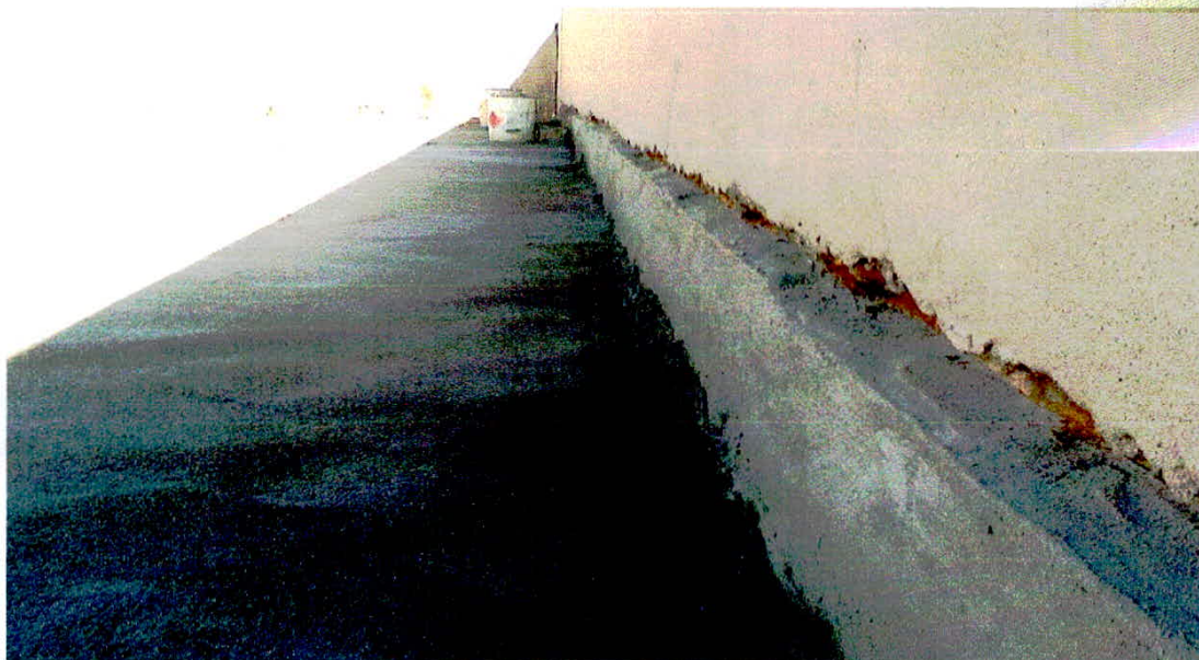
Figura 12 – Corte dos Rodapés
