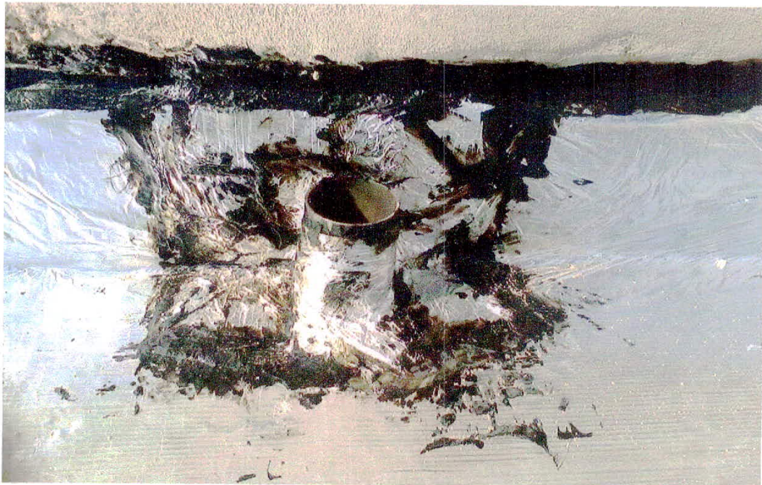
Figura 18 – Ralos e Tubulações
