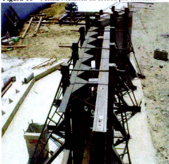
Figura 18 – Forma Metálica da escada pré-moldada
