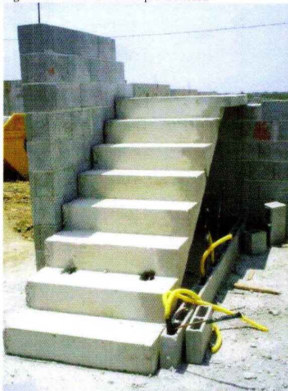
Figura 16 - Lance da escada pré-fabricada
