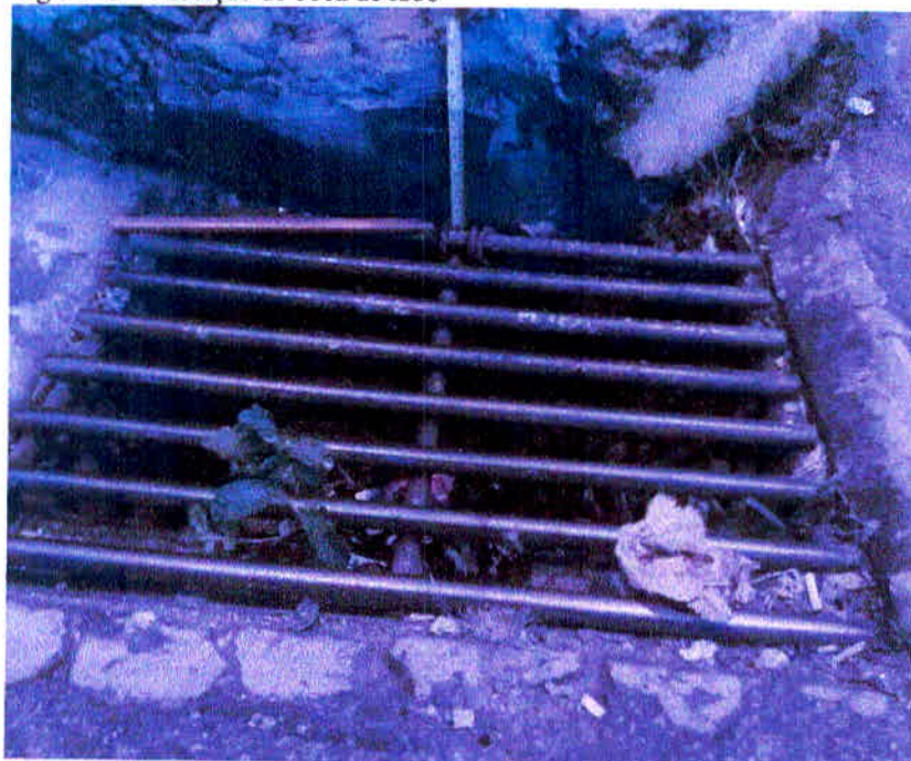
Figura 13 – Medição de boca de lobo
