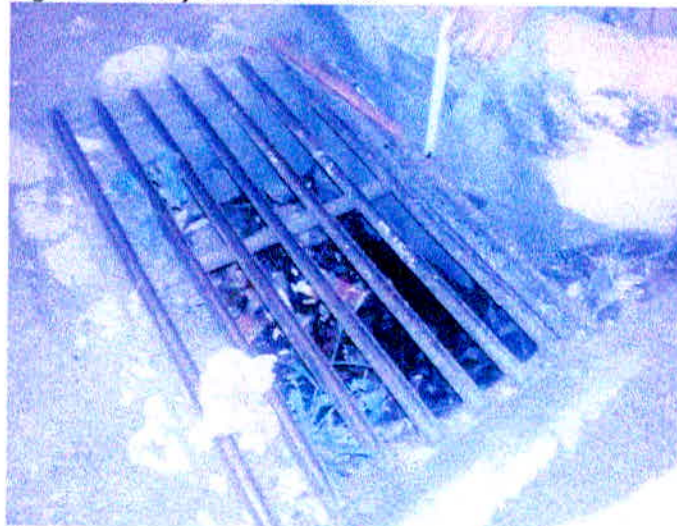
Figura 4 – Medição de boca de lobo
