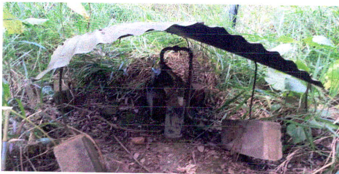
Figura 5 – Poço semi-artesiano que abastece a parte central do bairro Bárbaras.
