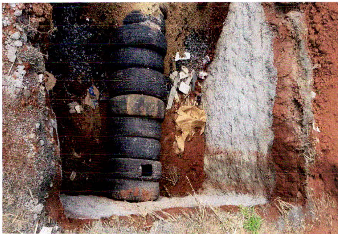
Figura 2 – Fossa ecológica em fase construtiva.
