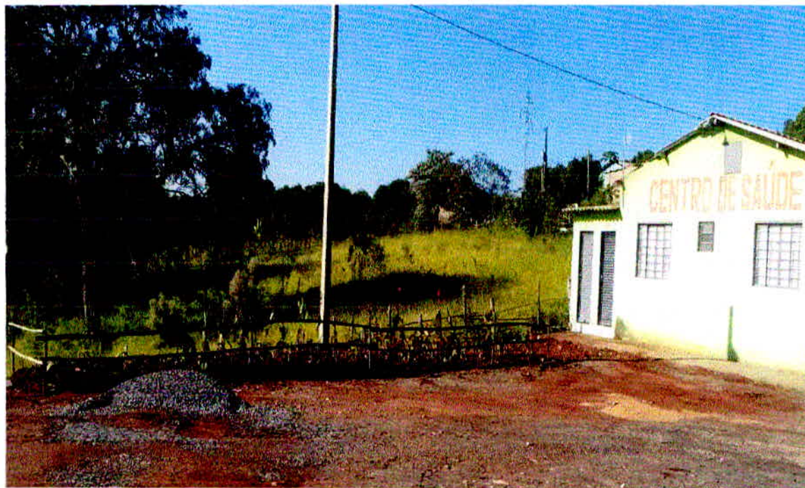
Figura 1 – Fossa ecológica construída no Centro de Saúde do bairro Bárbaras, Alfenas/MG.
