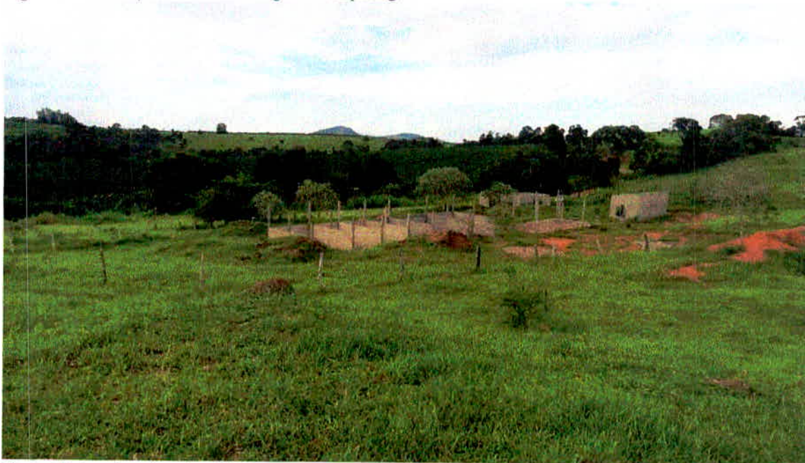
Figura 21: construção da usina de triagem e compostagem
