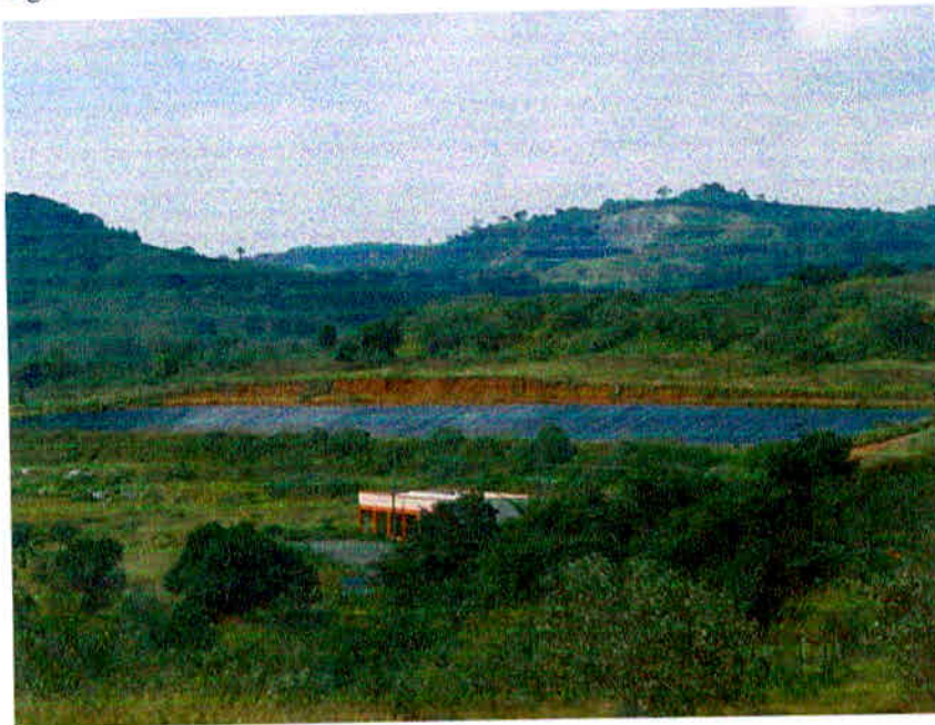
Figura 14: Vista da área aonde será construído o Aterro Sanitário.
