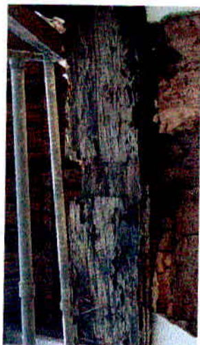
Figura 11 – Vista mediana do Pilar 9.
