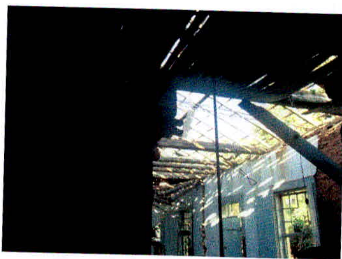
Figura 17 – Seção dos banzos inferiores da estrutura do telhado.
