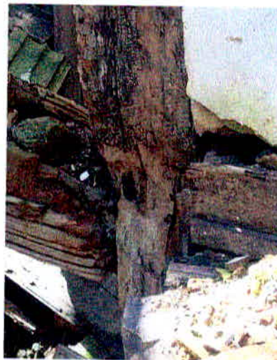
Figura 12 – Vista da base inferior do Pilar 9.
