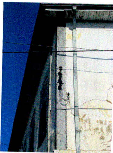
Figura 16– Vista do Pilar 15.
