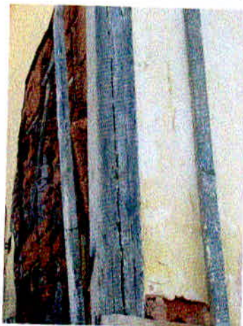
Figura 14 – Vista do Pilar 11.
