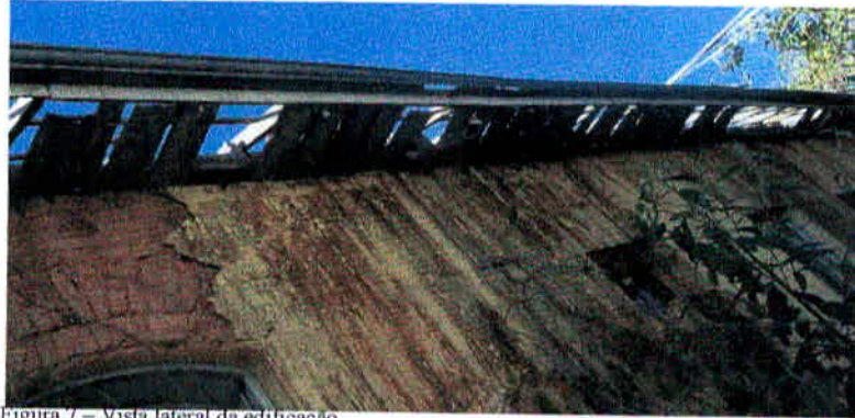
Figura 7 – Vista lateral da edificação.
