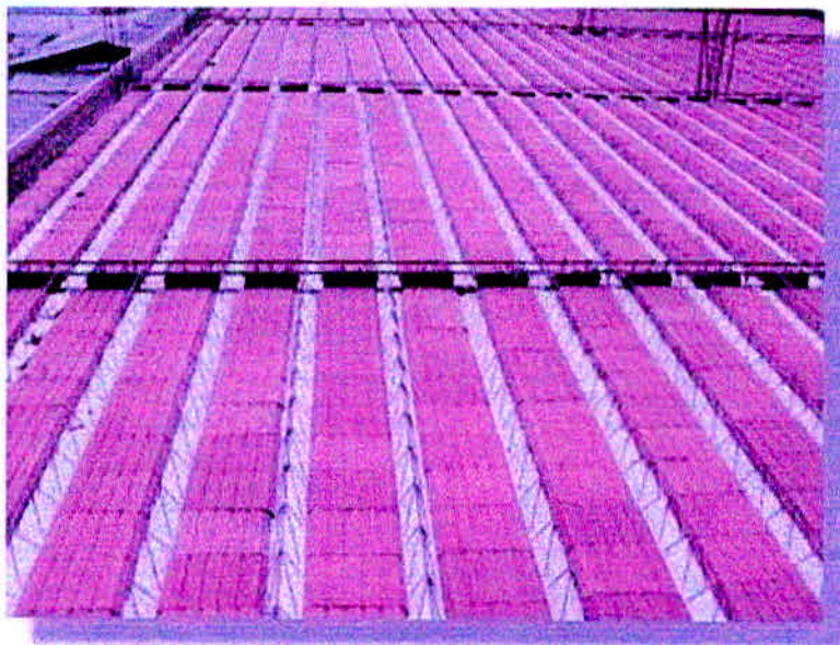
Figura 06 - Laje nervurada pré-moldada.
