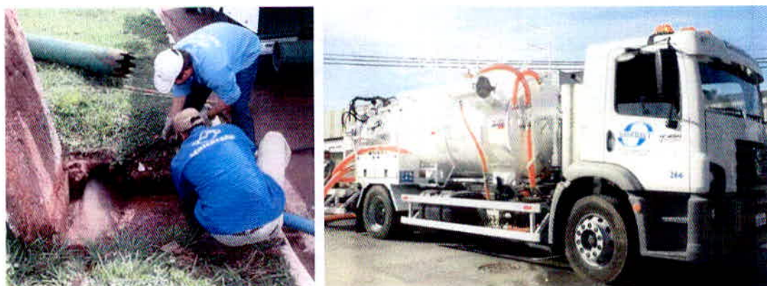
Figura 14 :a) Limpeza de galerias por hidrojateamento; b) caminhão de hidrojateamento Fonte: Internet
