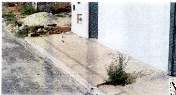
Figura 02: Sarjeta e meio-fio Fonte: Google Earth
