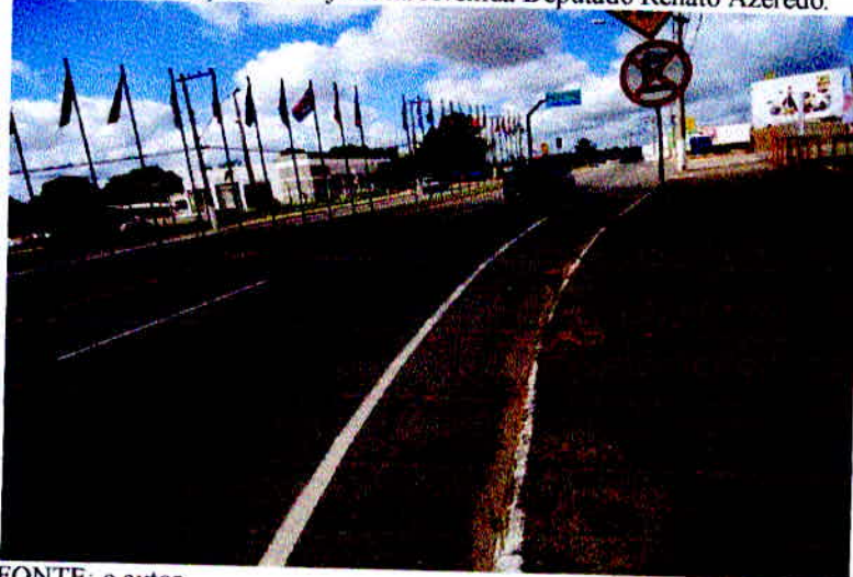
Figura 05: Condição das sarjetas na Avenida Deputado Renato Azeredo.
