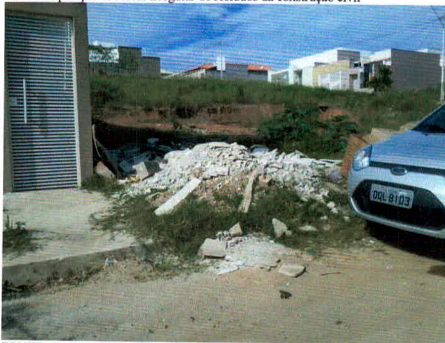
FIG 7: Deposição em local irregular de resíduos da construção civil
