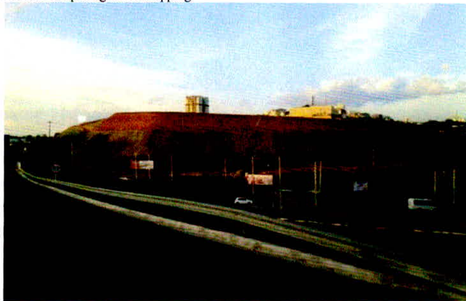
FIG 8: Terraplanagem do shopping.
