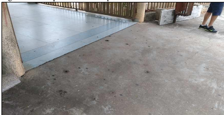
Figura 3 – Rampa de acesso ao pavimento térreo
