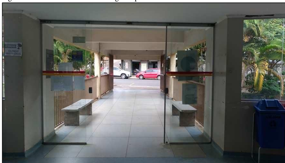
Figura 2 – Porta de acesso e descarga do pavimento térreo
