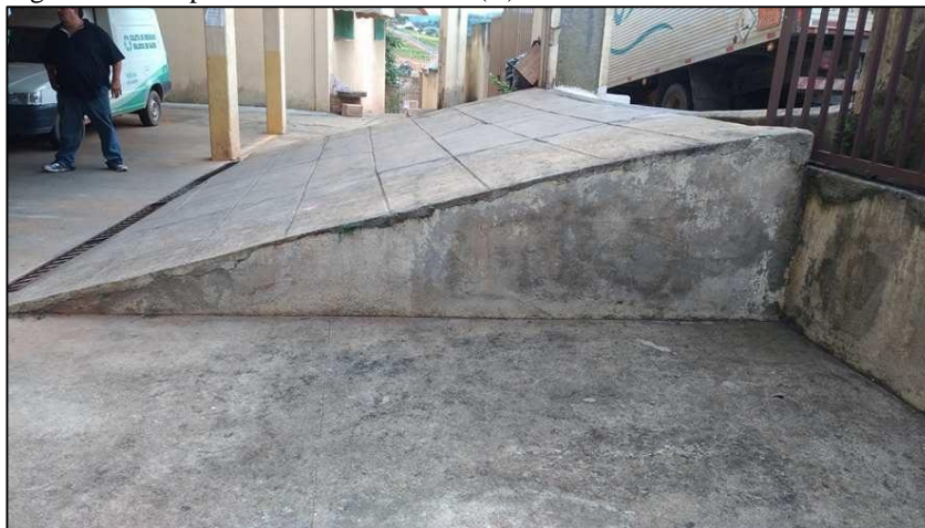
Figura 5 – Rampa de acesso ao subsolo (II)
