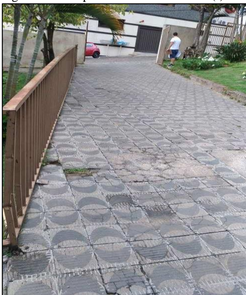
Figura 4 – Rampa de acesso ao subsolo (I)
