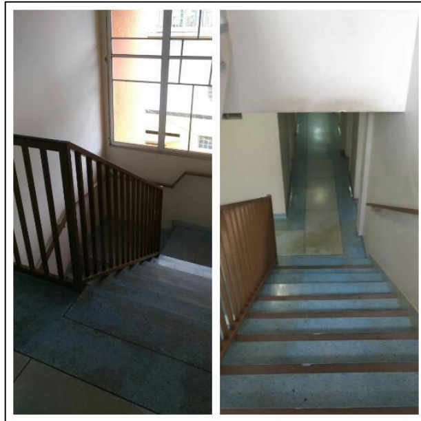
Figura 6 – Escada 1 que liga o pavimento térreo aos subsolos (I) e (II)
