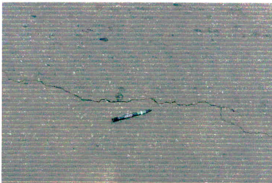
Figura 5 – Trincamento longitudinal.
