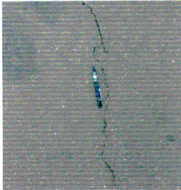
Figura 6 – Trincamento transversal.
