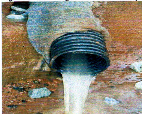
Figura 30 - Saída de água do tubo dreno MacPipe.
