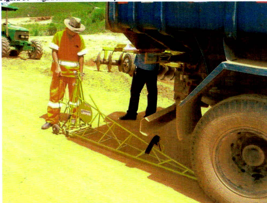
Figura 14 - Viga Benkelman em utilização.
