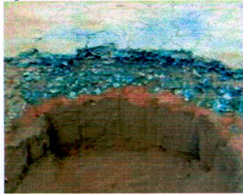
Figura 9 - Camadas constituintes do pavimento.
