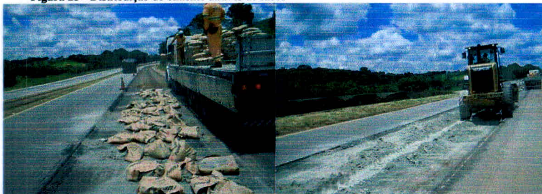
Figura 25 - Distribuição do cimento através de sacos
