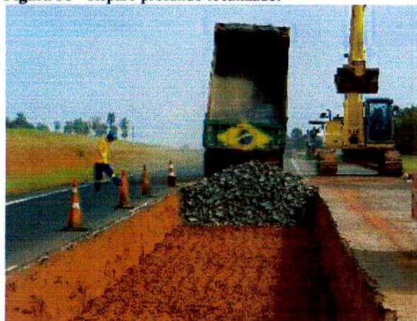
Figura 38 - Reparo profundo localizado.
