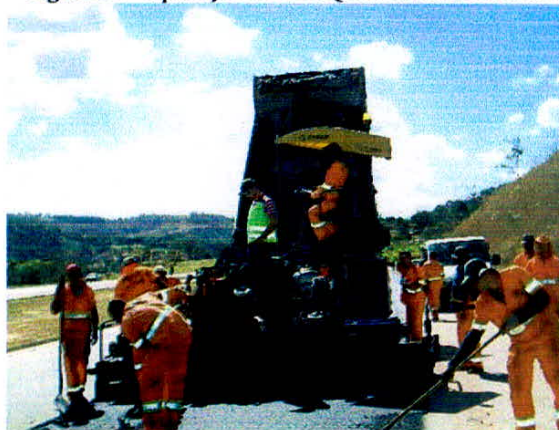
Figura 36 - Aplicação do CBUQ com vibroacabadora
