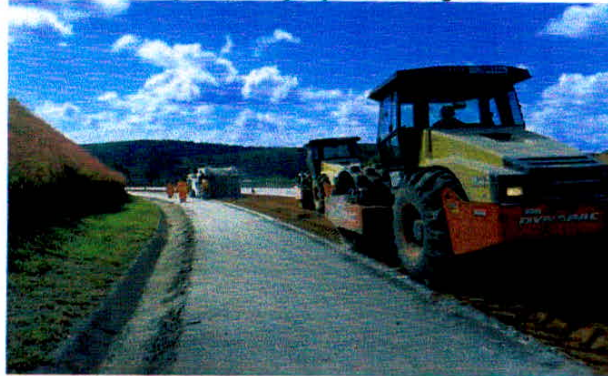
Figura 27 - Compactação logo após a reciclagem
