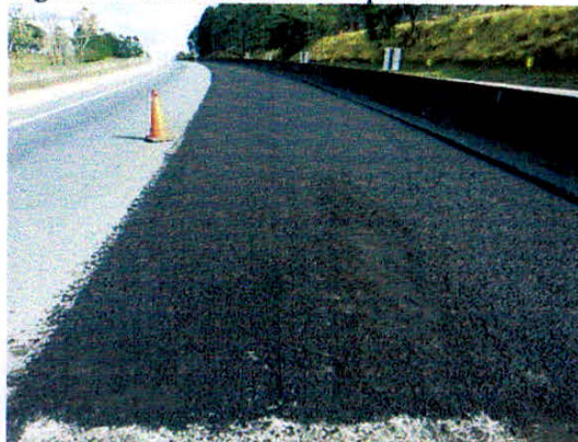
Figura 34 - Microrrevestimento aplicado
