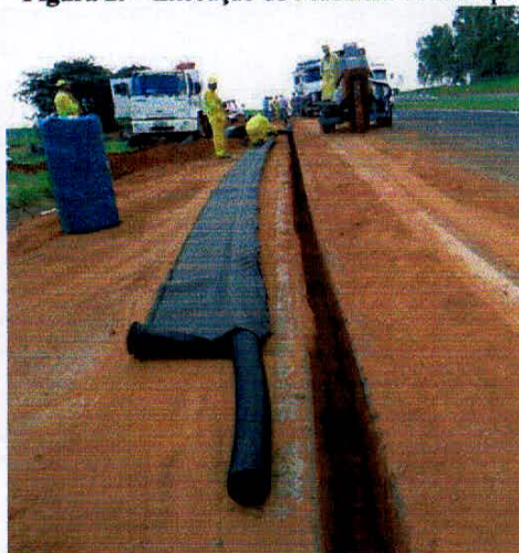
Figura 29 - Execução do Macdrain e MacPipe
