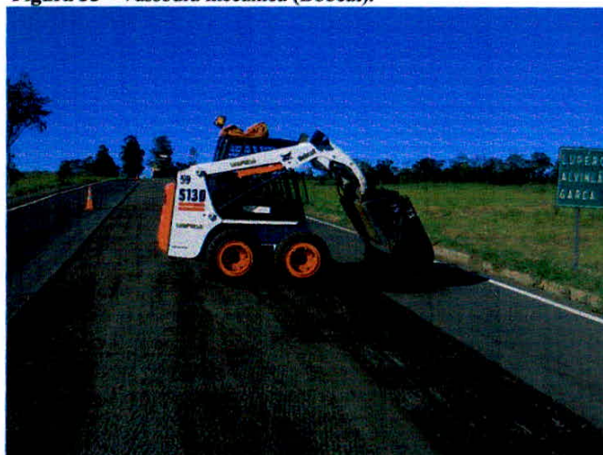
Figura 33 - Vassoura mecânica (Bobcat).
