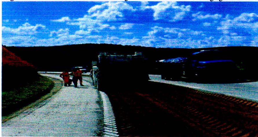
Figura 22 - Recicladora realizando a homogeneizando do cimento e dos agregados da base.
