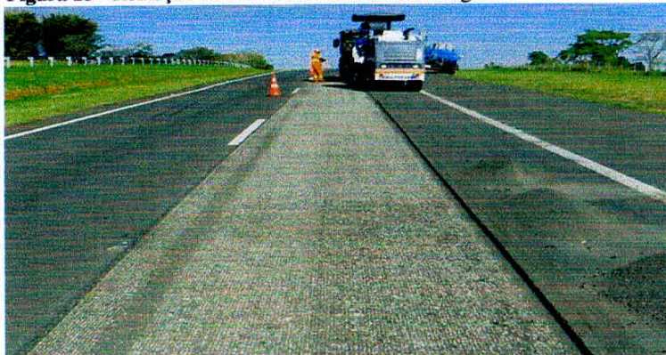
Figura 23 - Remoção do Pavimento através da Fresagem.
