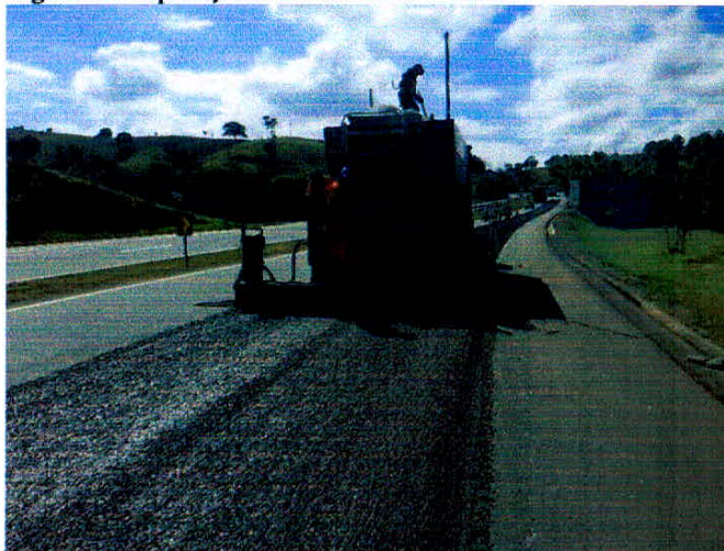
Figura 35 - Aplicação do microrrevestimento
