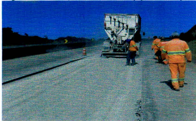
Figura 26 - Distribuição do cimento com equipamento adequado
