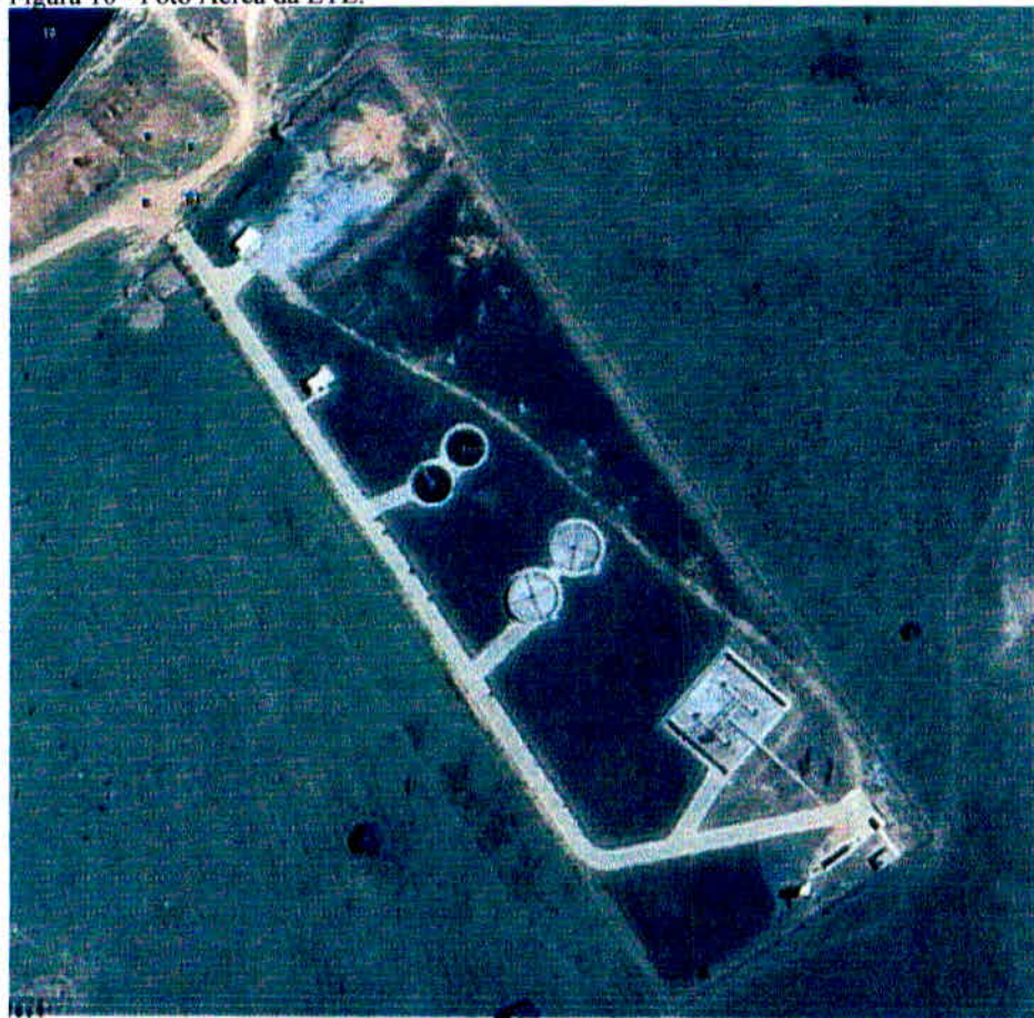
Figura 10 - Foto Aérea da ETE.
