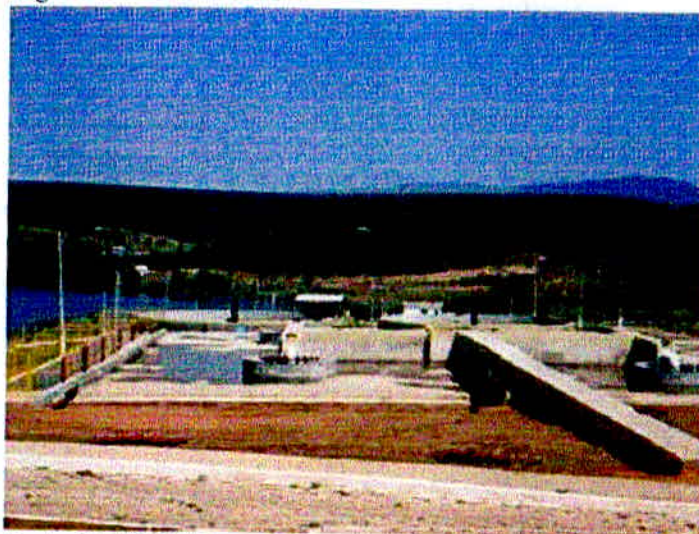
Figura 12 - Vista da ETE.
