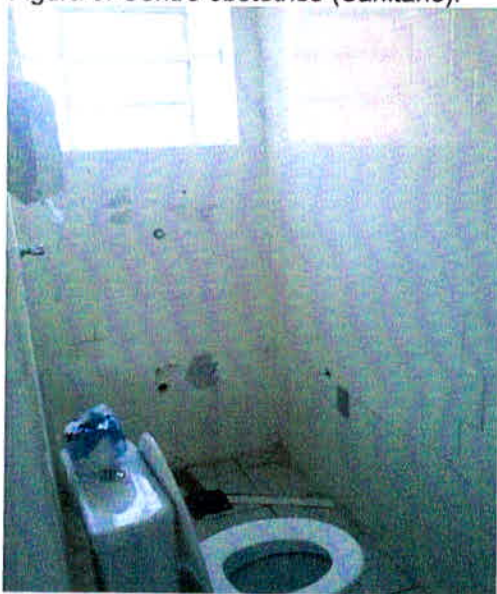
Figura 3: Centro obstétrico (Sanitário).
