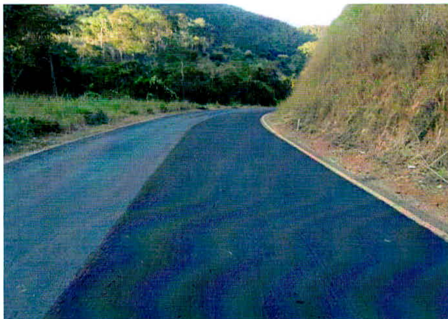
Figura 21– Lama Asfáltica executada
