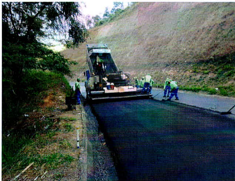
Figura 24 – Aplicação de CBUQ
