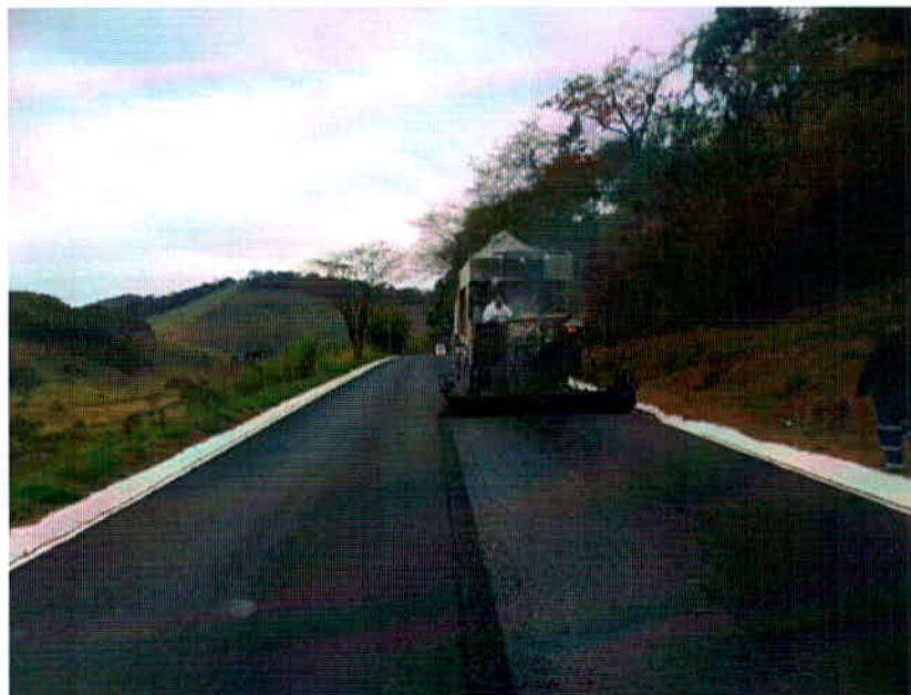
Figura 23 – Aplicação de Microrrevestimento Asfáltico
