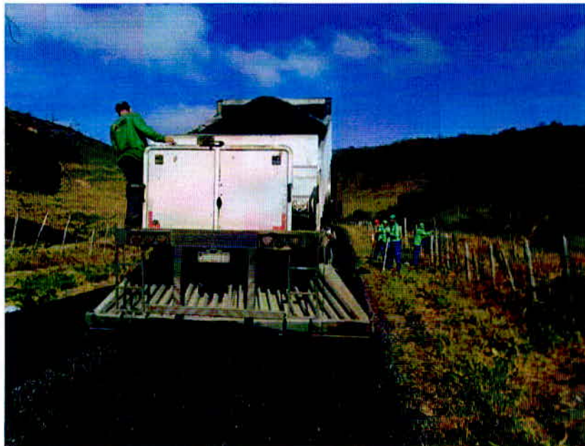
Figura 22– Tratamento Superficial Simples sendo executado
