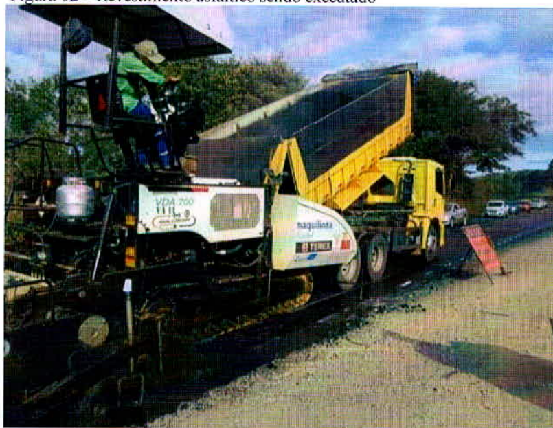
Figura 02 – Revestimento asfáltico sendo executado
