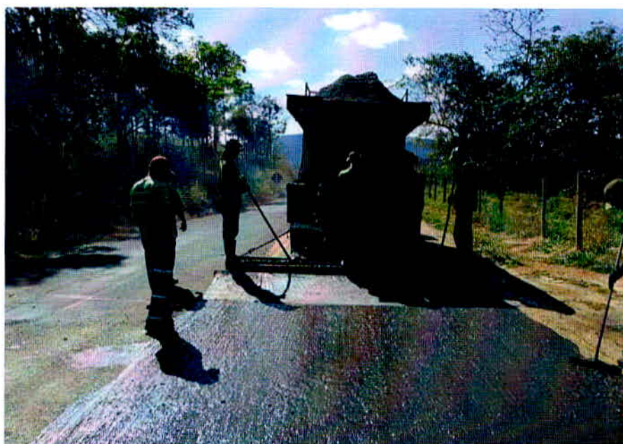
Figura 20– Aplicação de Lama Asfáltica
