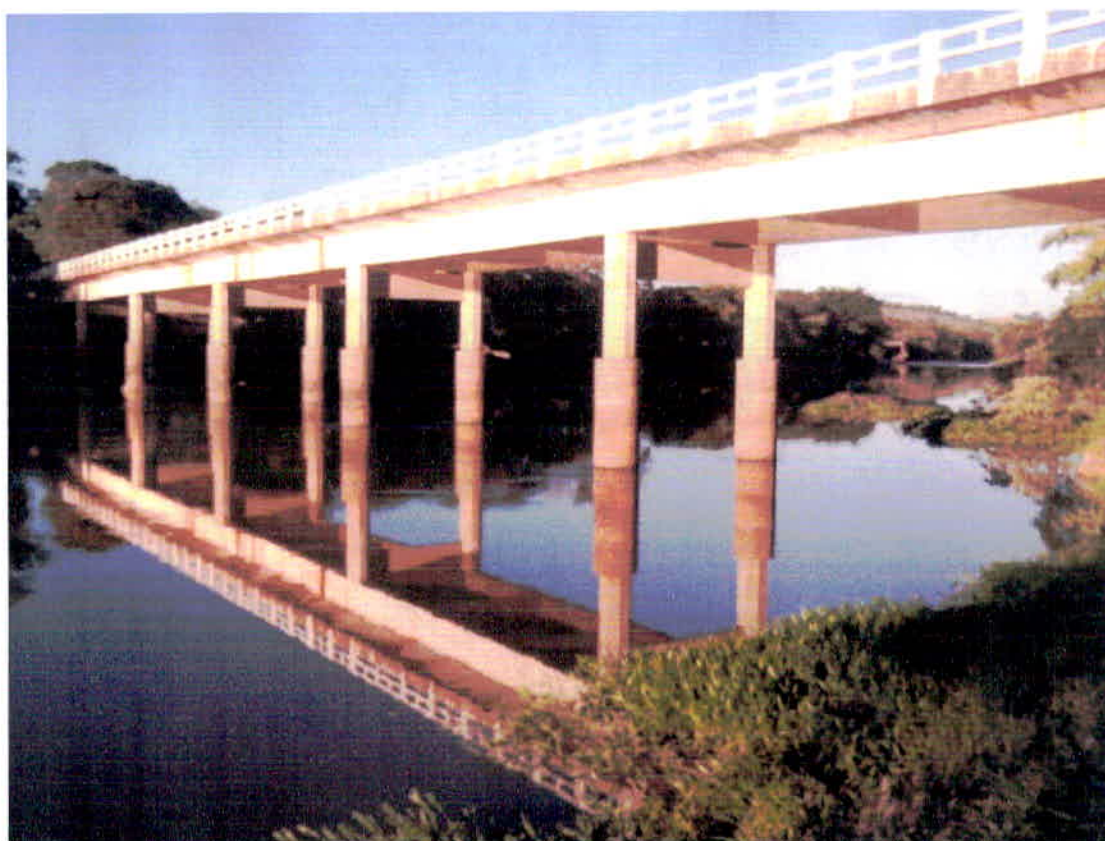
Figura 45 – Foto 11 Vista Geral Inferior
