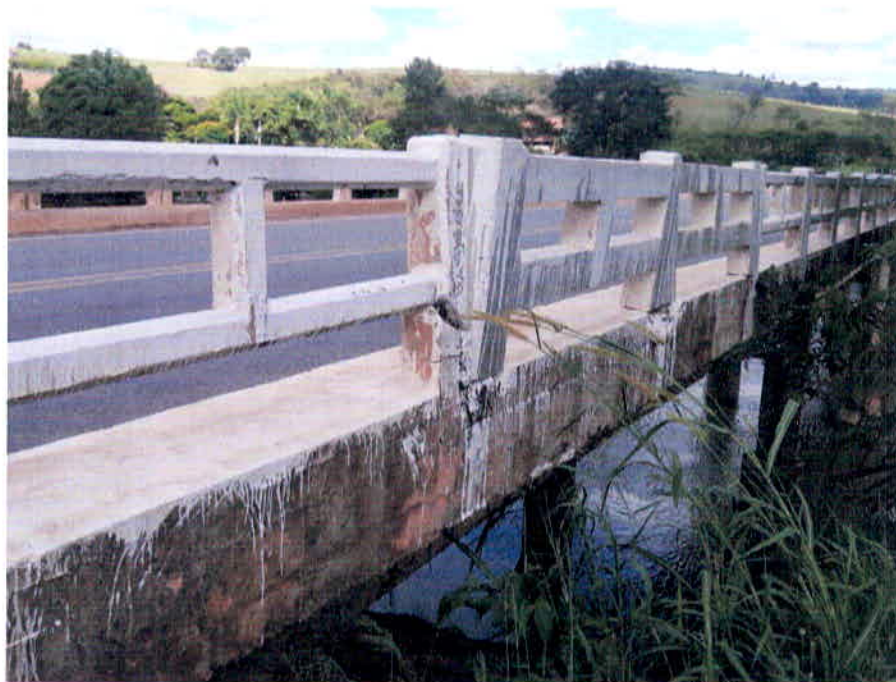
Figura 42 – Foto 08 Vista Superior – Guarda Corpo de Concreto Armado
