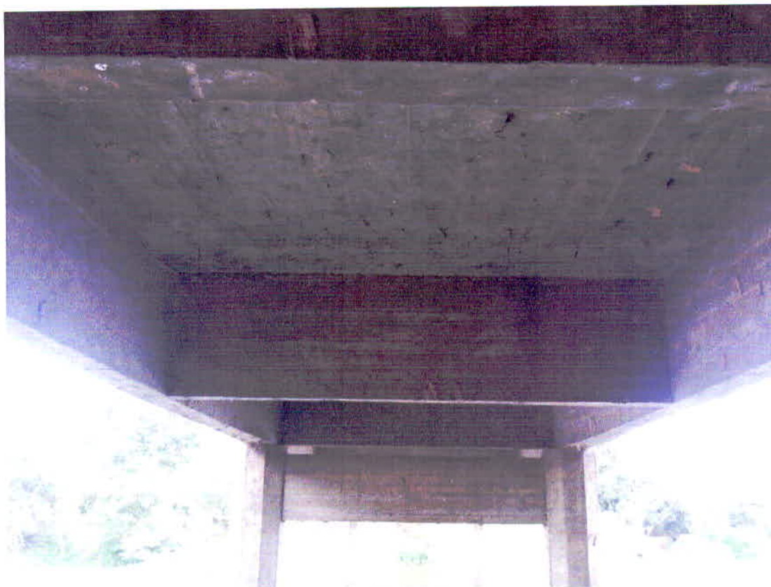
Figura 43 – Foto 09 Vista Inferior – Estrutura
