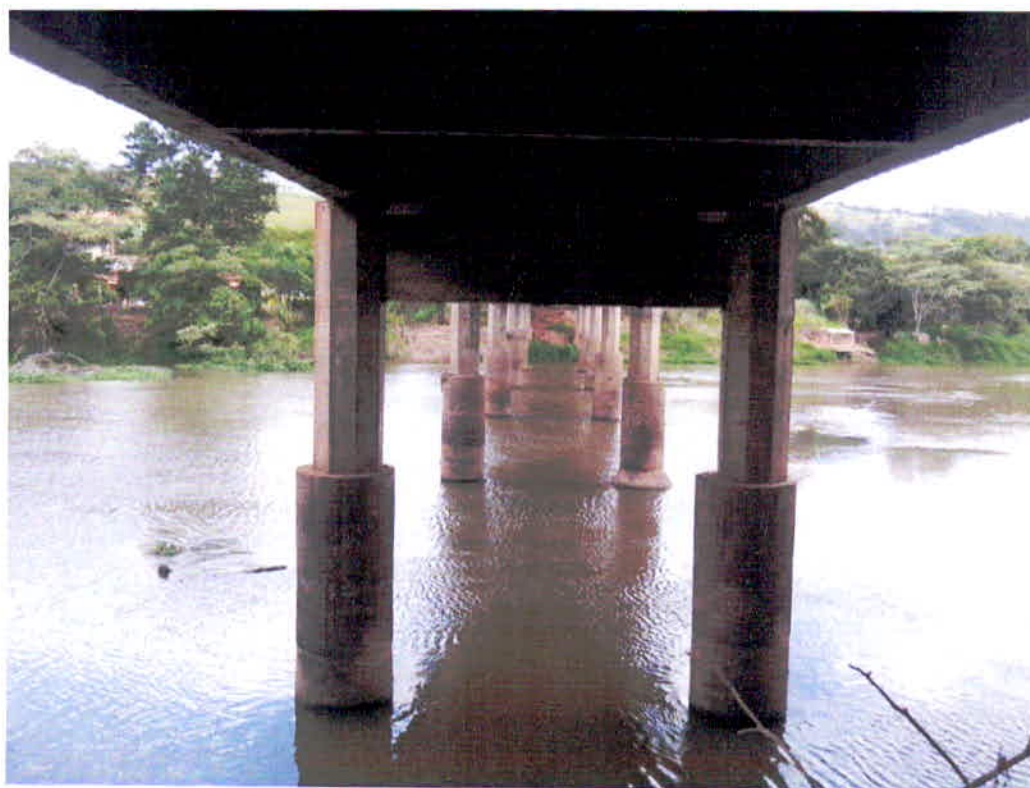
Figura 36 – Foto 02 Vista Inferior – Estrutura
