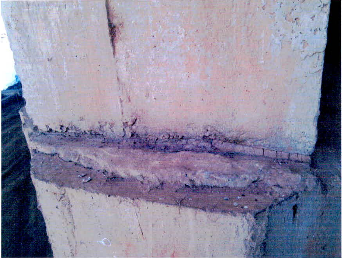
Figura 50 – Foto 16 Vista Inferior – Aparelho de Apoio
