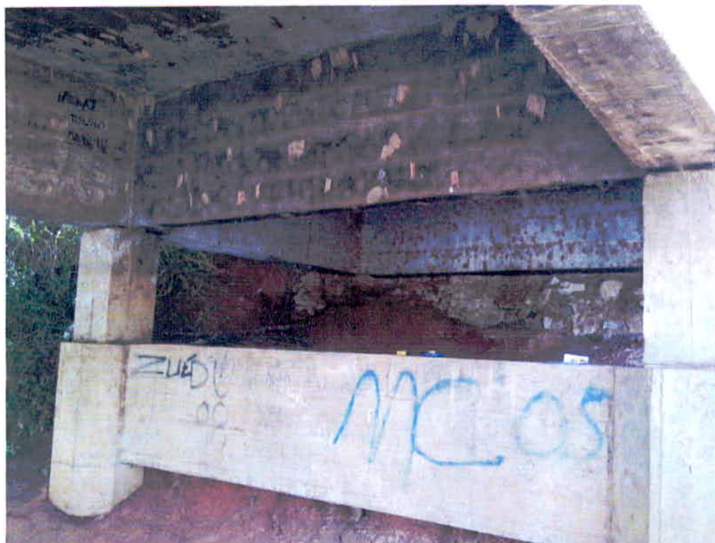
Figura 35 – Foto 01 Vista Inferior – Estrutura
