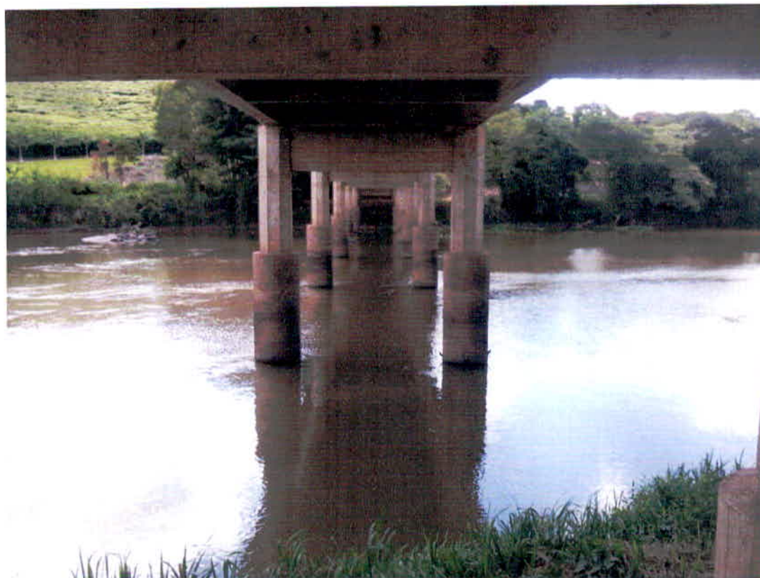
Figura 39 – Foto 05 Vista Inferior – Estrutura
