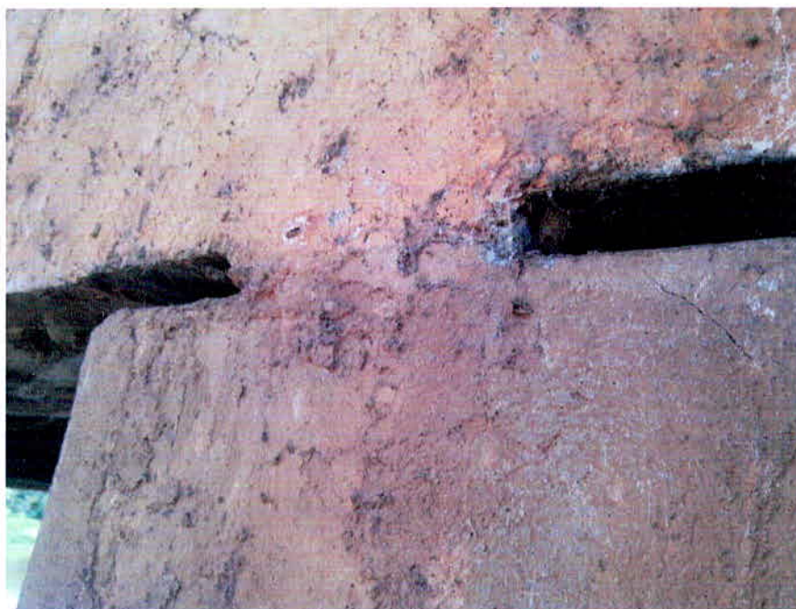
Figura 49 – Foto 15 Vista Inferior – Aparelho de Apoio
