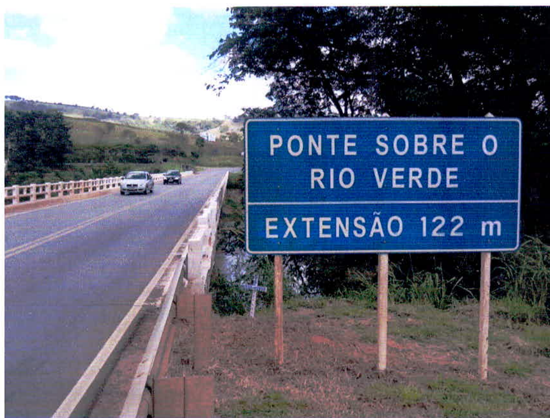
Figura 44 – Foto 10 Vista Superior – Placa de Identificação da Obra de Arte
