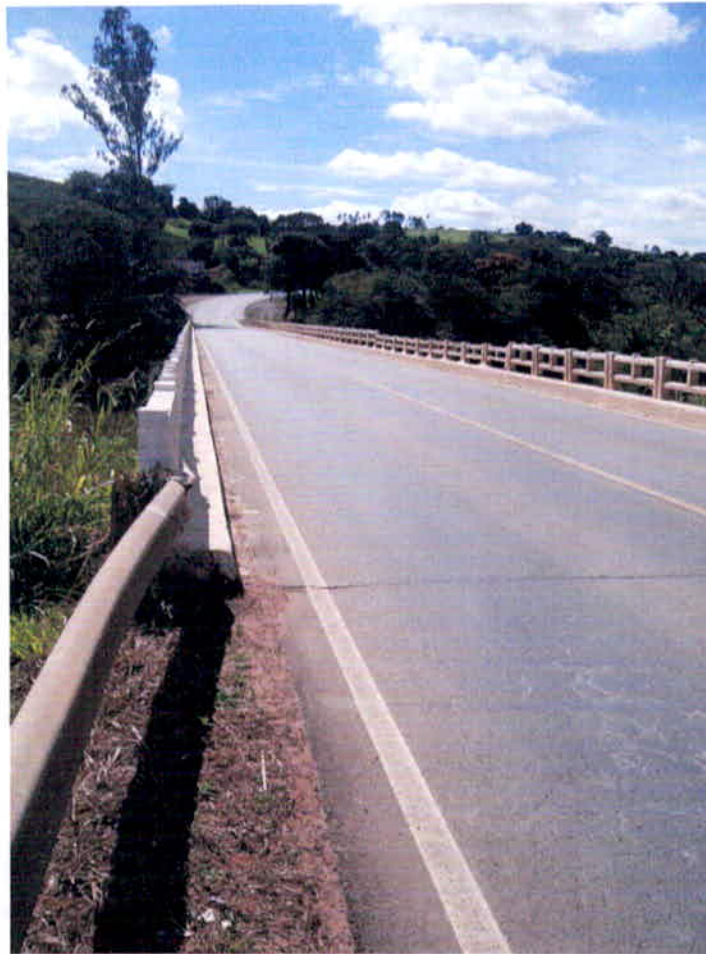
Figura 41– Foto 07 Vista Geral Superior – Sentido Município de Varginha
