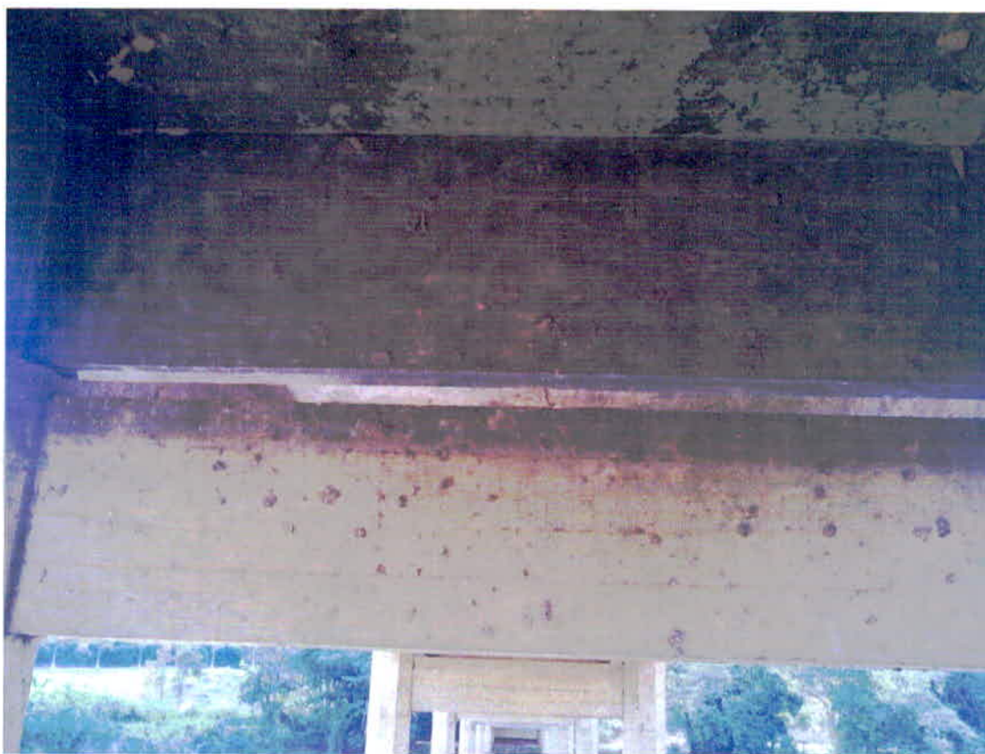
Figura 46 – Foto 18 Vista Inferior Estrutura
