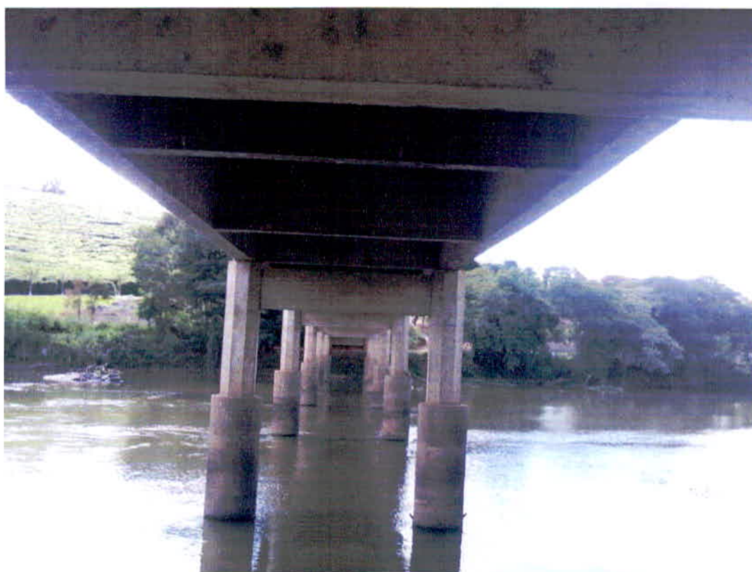
Figura 40 – Foto 06 Vista Inferior – Estrutura
