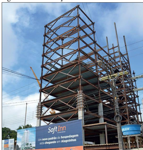
Figura 11 - Edificação feita em estrutura mista
