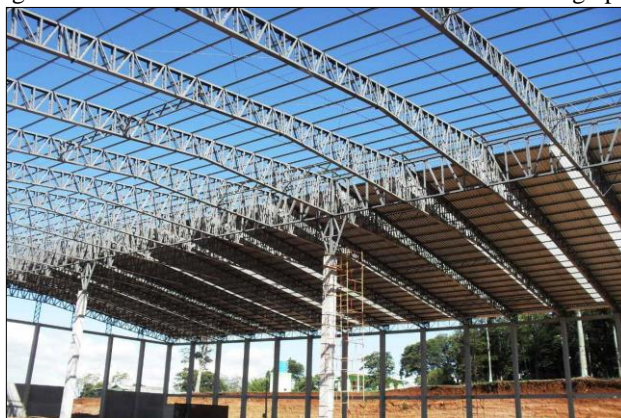
Figura 6 - Estrutura metálica utilizada na cobertura de galpão
