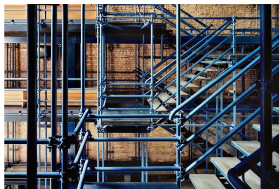
Figura 25 - Estrutura desmontável em aço
