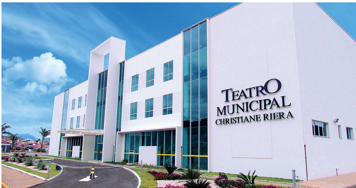
Figura 36 - Fachada principal Teatro Christiane Riêra
