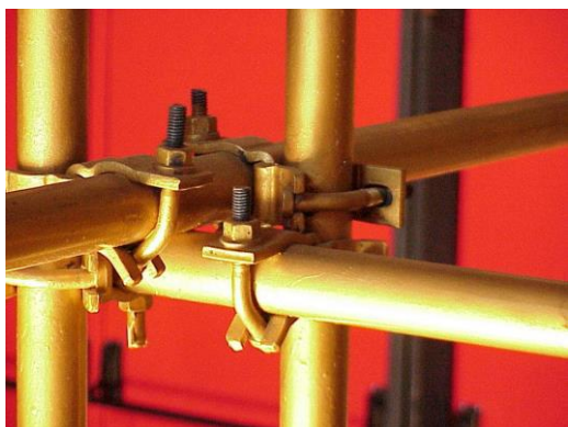
Figura 24 - Detalhamento nó estrutural
