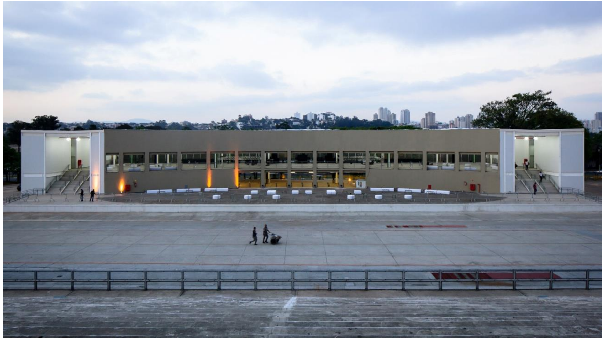
Figura 24- Fachada onde é possível ver os acessos verticais através das torres laterais.
