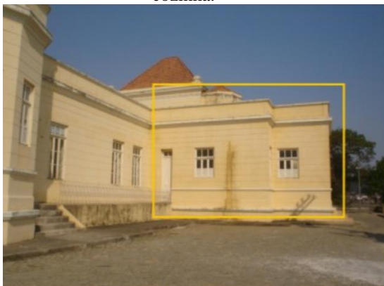
Figura 44- Volume adicionado usado como cozinha.
