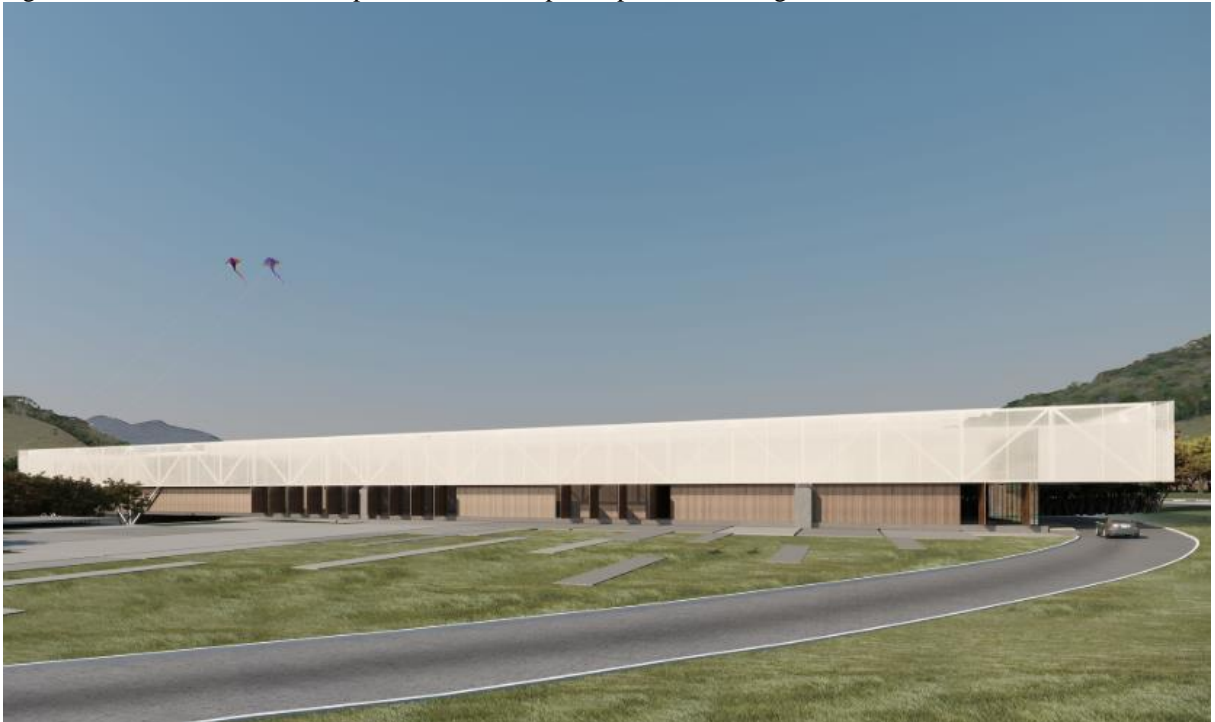
Figura 17- Fachada norte onde é possível observar portas pivotantes integrando os ambientes internos e externos.
