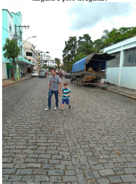
Figura 38- Imagem onde é possível observar largura e piso irregular.
