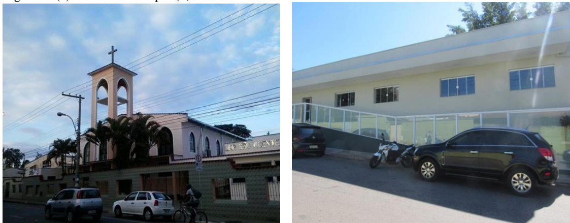
Figura 9: (a) Fachada Principal (b) Acesso ao Lar São Vicente.
