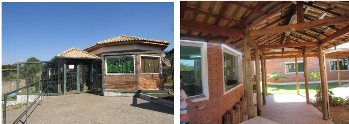
Figura 13: (a) Entrada Principal do Centro de Convivência de Idoso (b) Vista Interna do Centro de Convivência de Idoso.
