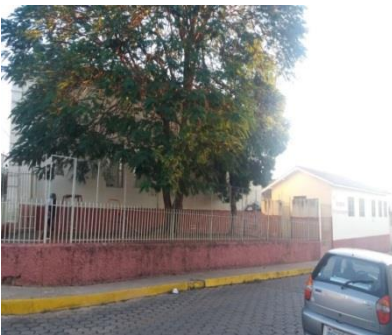
Figura57: Arborização na creche
