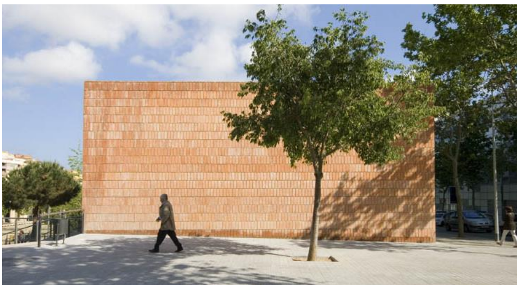
Figura 28- Fachada revestida de tijolo a vista.
