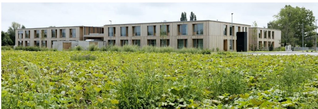
Figura 20- Fachada principal do edifício.
