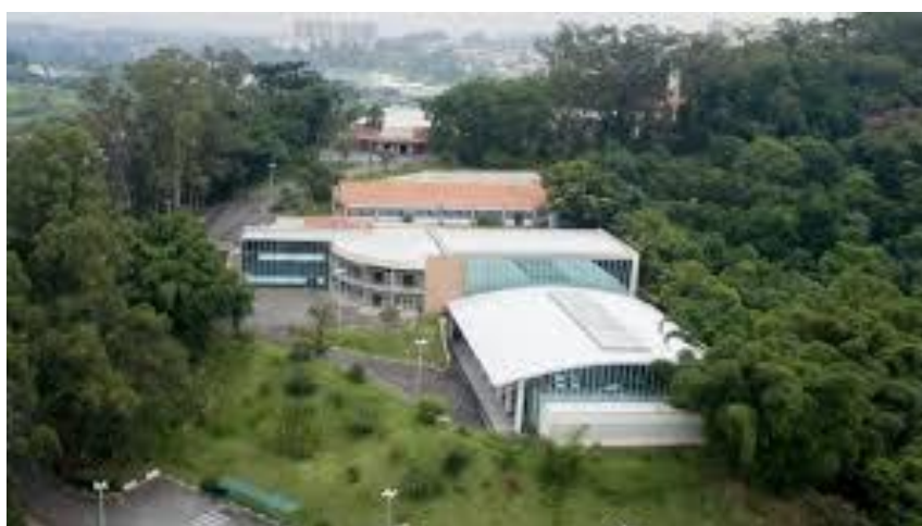
Figura 32- Edifício e seu entorno.
