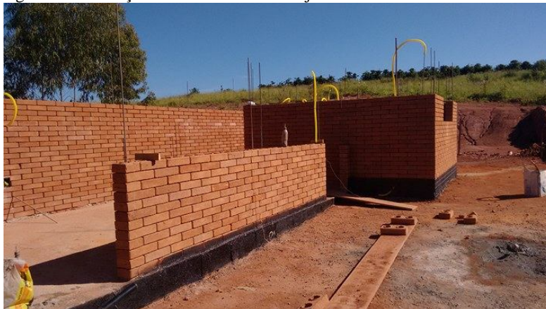
Figura 11: Instalações elétricas executadas junto com a alvenaria
