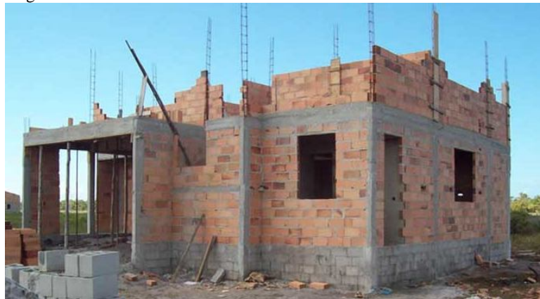
Figura 02: Obra em sistema construtivo de concreto armado
