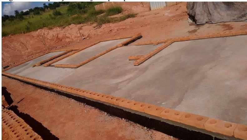
Figura 10: Disposição dos tijolos para primeira fiada
