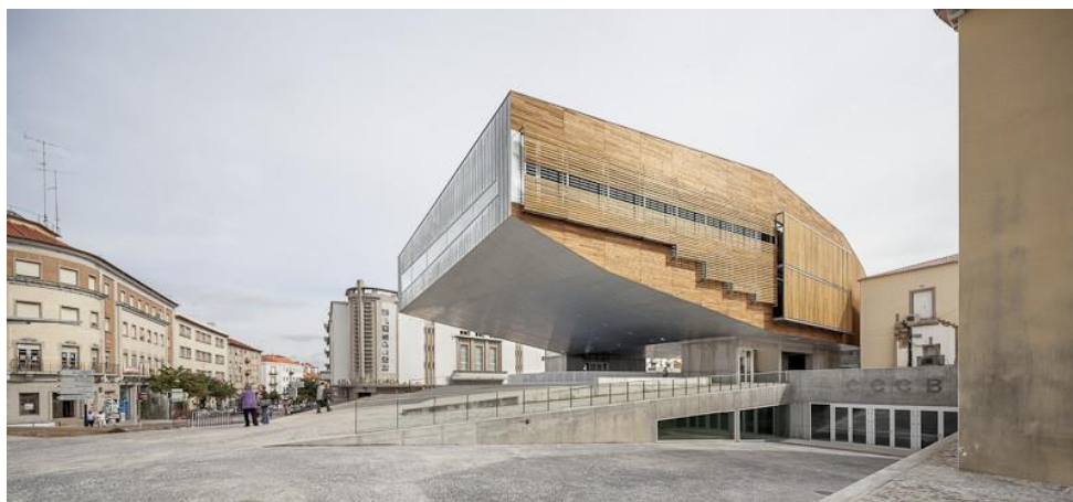
Figura 35 – Detalhes construtivos em madeira.
