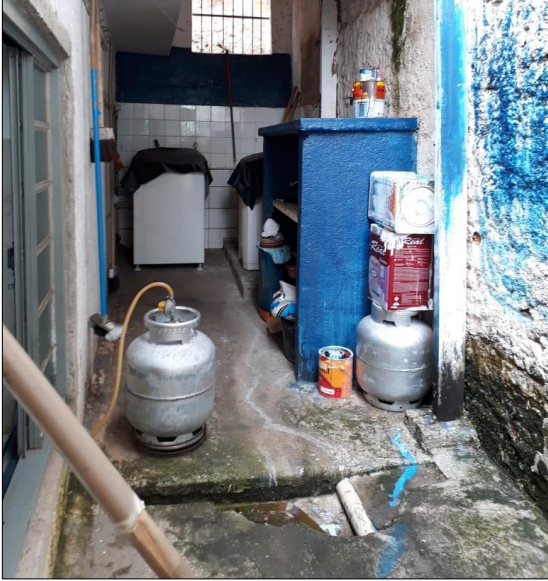
Figura 7: Albergue de Alfenas - MG (e) lavanderia
