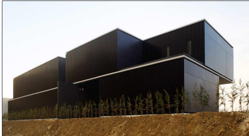
Figura 26: Vista Aproximada Fachada Principal Shelter Home.
