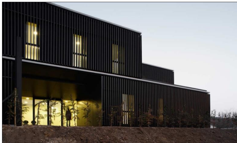
Figura 27: Vista Lateral Direita Shelter Home.
