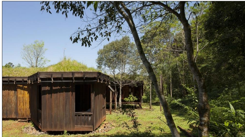
Figura 19: Vista Lateral Esquerda Albergue Comuna Yervas del Paraíso.
