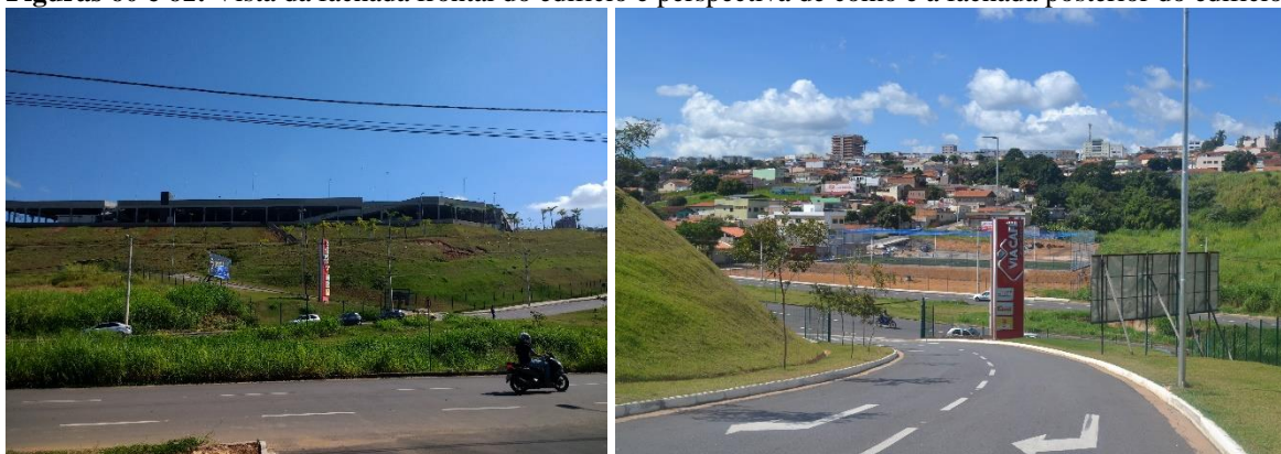
Figuras 60 e 61: Vista da fachada frontal do edifício e perspectiva de como é a fachada posterior do edifício.
