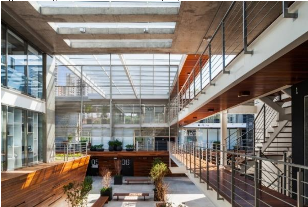
Figura 36. Imagem do interior do edifício Corujas 3, São Paulo.
