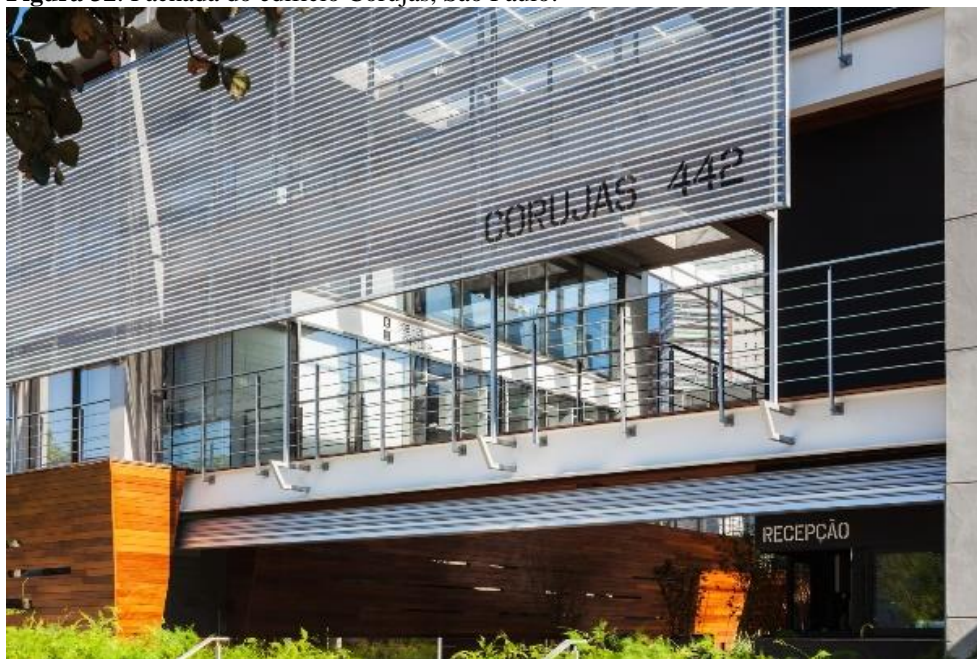
Figura 32. Fachada do edifício Corujas, São Paulo.
