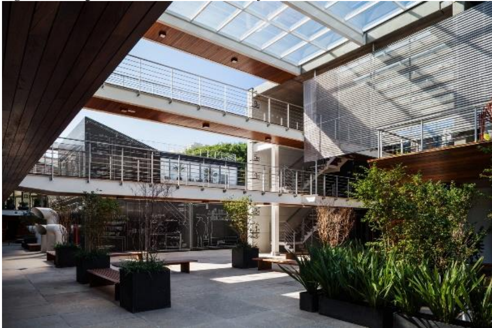
Figura 35. Imagem do interior do edifício Corujas 2, São Paulo.
