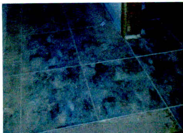
Figura 12 – Etapa 4 - Assentamento Piso Cerâmico
