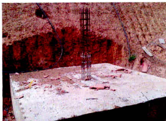
Figura 8 – Etapa 1 – Bloco de fundação
