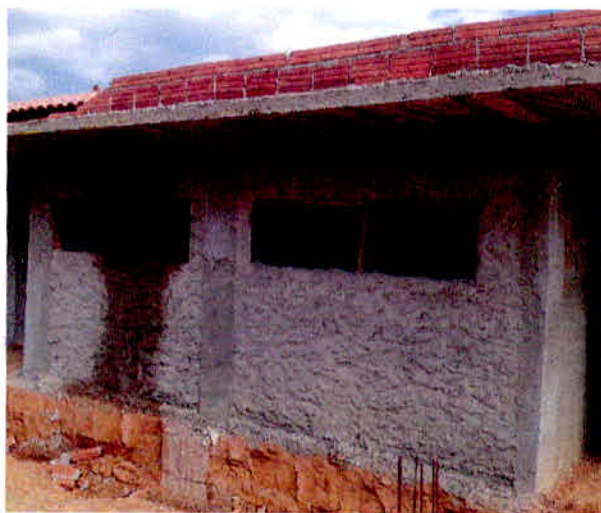
Figura 10 – Utilização da argamassa
