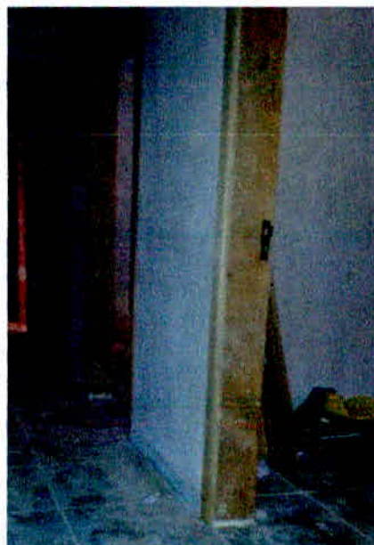
Figura 13 – Etapa 5 - Fixação da esquadria
