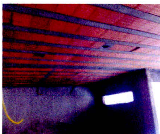
Figura 14 – Etapa 6 – Laje pré-moldada
