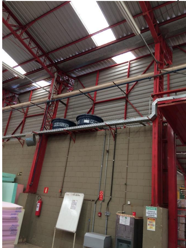
Figura 16 - Condutor horizontal existente no local, Galpão 3
