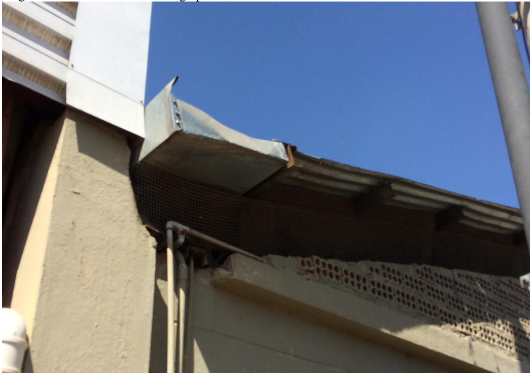
Figura 18 - Calhas existente no galpão 1
