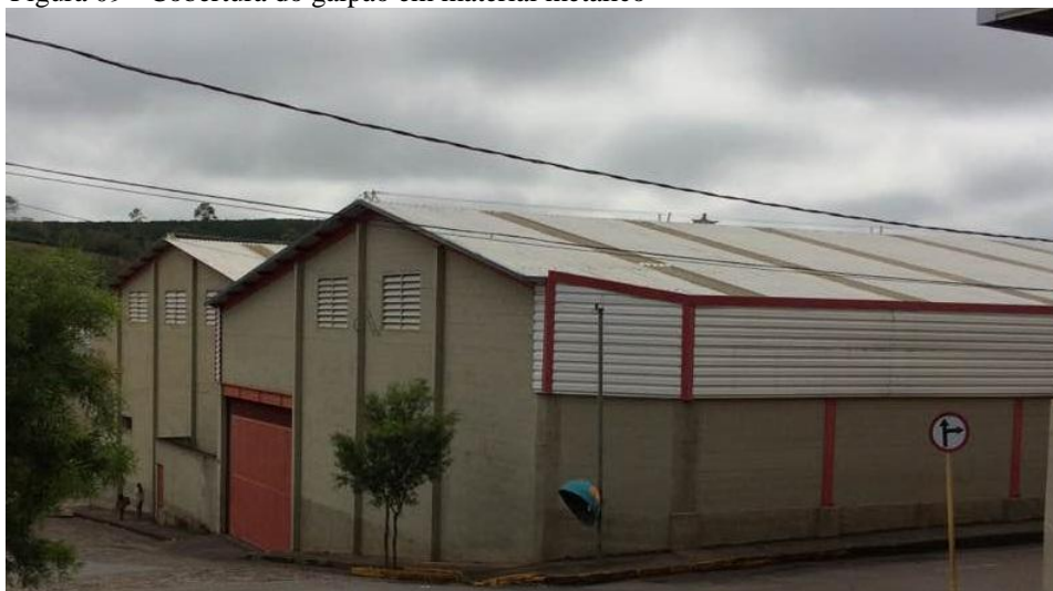
Figura 09 - Cobertura do galpão em material metálico
