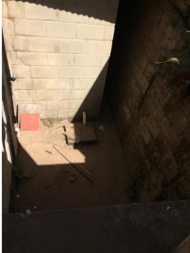
Figura 17 - Área disponível para o reservatório inferior
