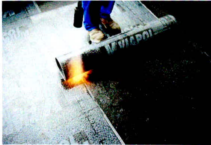
Figura 10 – Execução da manta asfáltica com maçarico.
