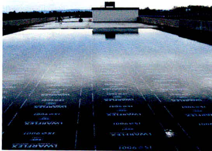
Figura 11 – Teste de estanqueidade.
