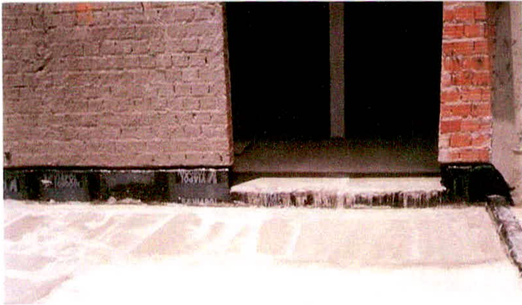
Figura 14 – Rodapé com impermeabilização.
