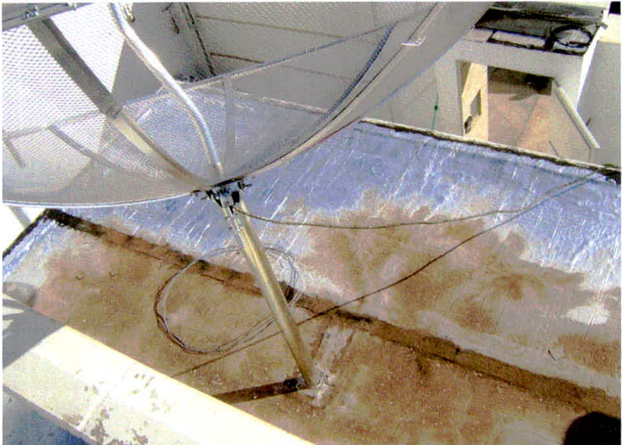
Figura 25– Laje analisada pelo autor, já impermeabilizada com manta asfáltica.
