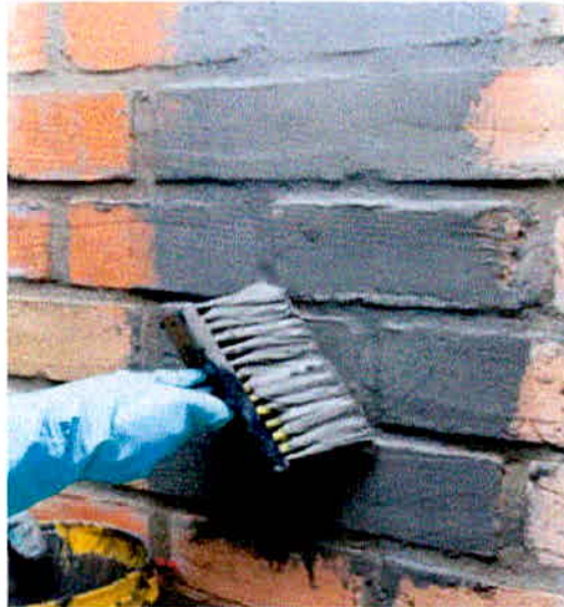
Figura 4 – Aplicação do cristalizante na forma de pintura.
