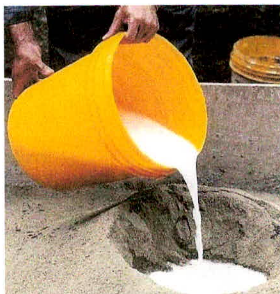
Figura 3 – Preparação da argamassa com aditivo hidrófugo.
