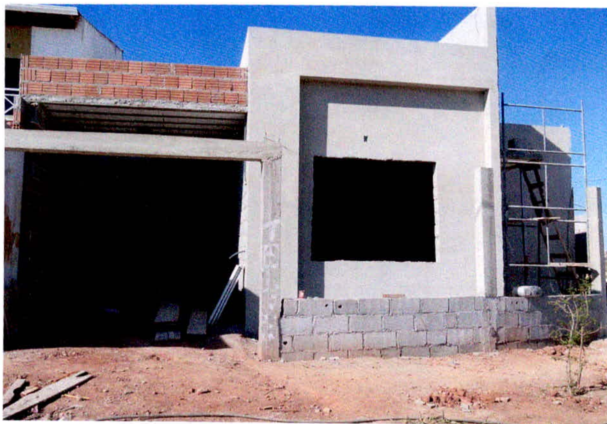
Figura 38– Residência em que foi projetada a impermeabilização.
