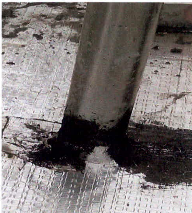
Figura 34 - Primeira etapa da impermeabilização no chumbamento.
