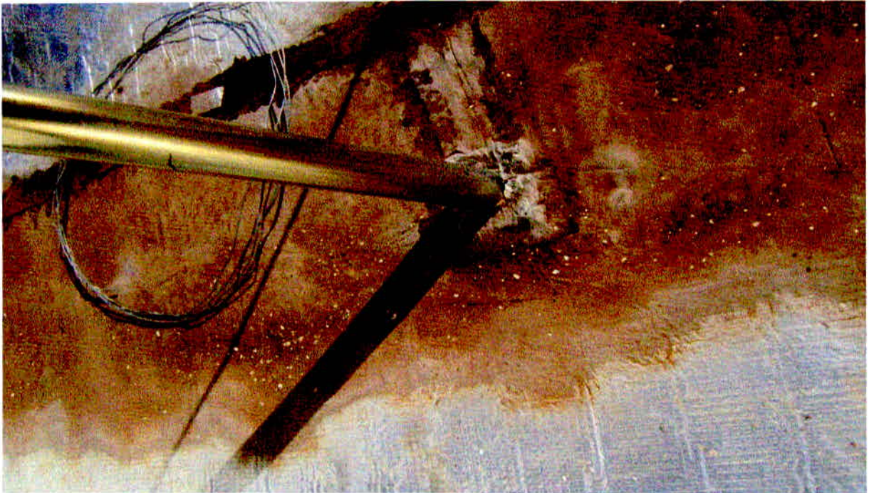
Figura 28 –Detalhe na impermeabilização no poste da antena de TV.
