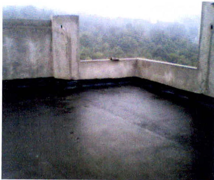
Figura 9 – Imprimação da superfície.
