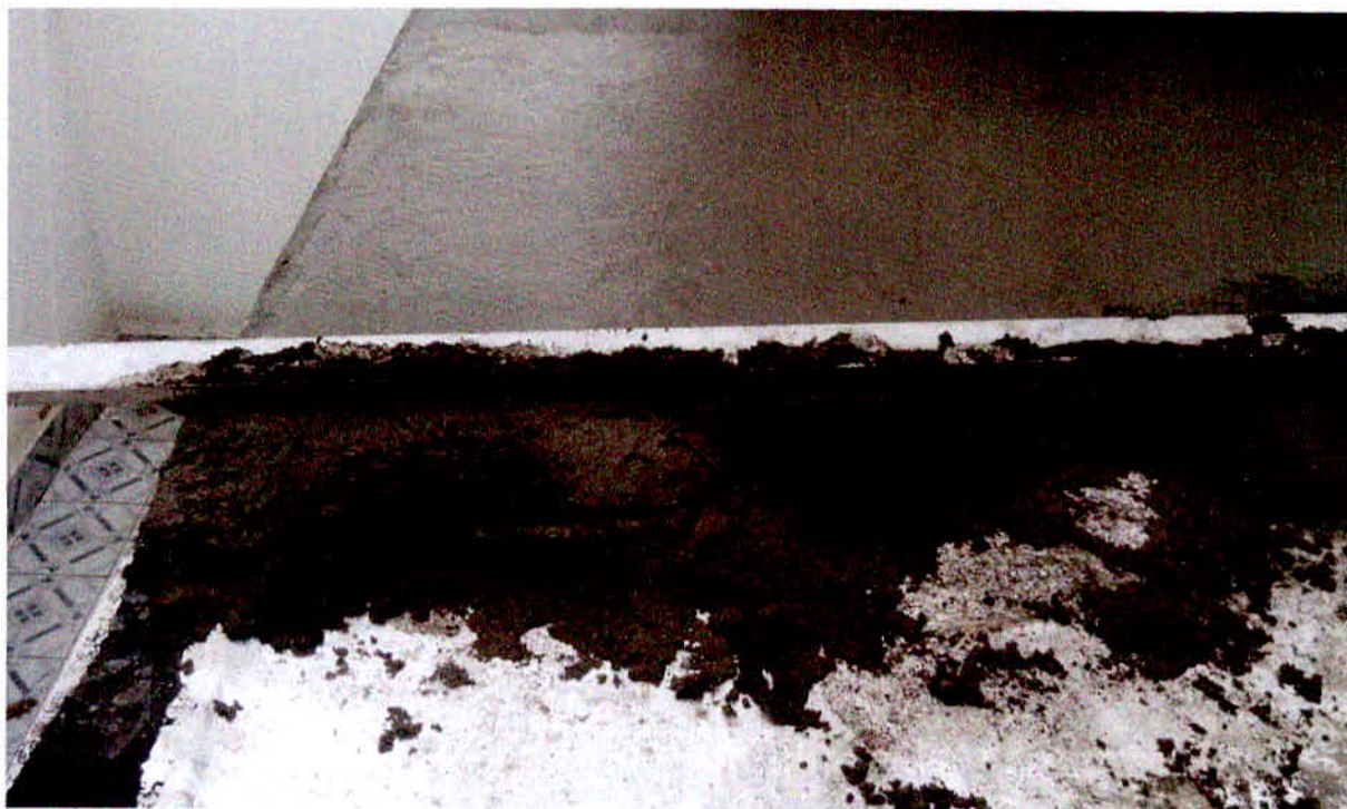
Figura 36 – Aplicação da argamassa de proteção com inclinação para o condutor de águas.
