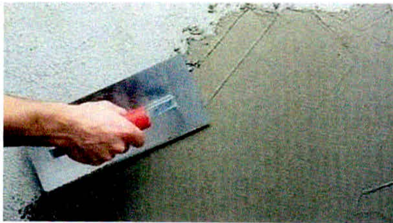
Figura 6 – Aplicação da argamassa polimérica na forma de revestimento.
