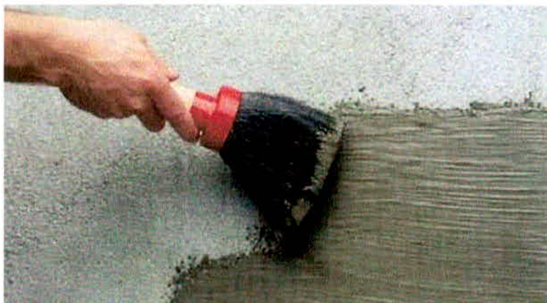
Figura 7 – Aplicação da argamassa polimérica na forma de pintura.
