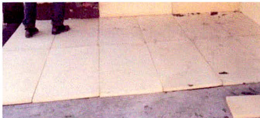
Figura 21 – Isolamento térmico com placas de poliestireno expandido moldado.
