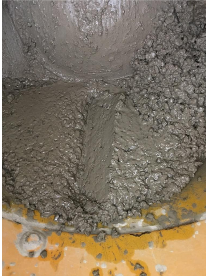
Figura 17 - Concreto (com brita 0) imprimido na betoneira.
