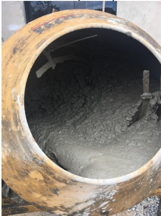
Figura 10 - Concreto sendo produzido por meio mecânico.
