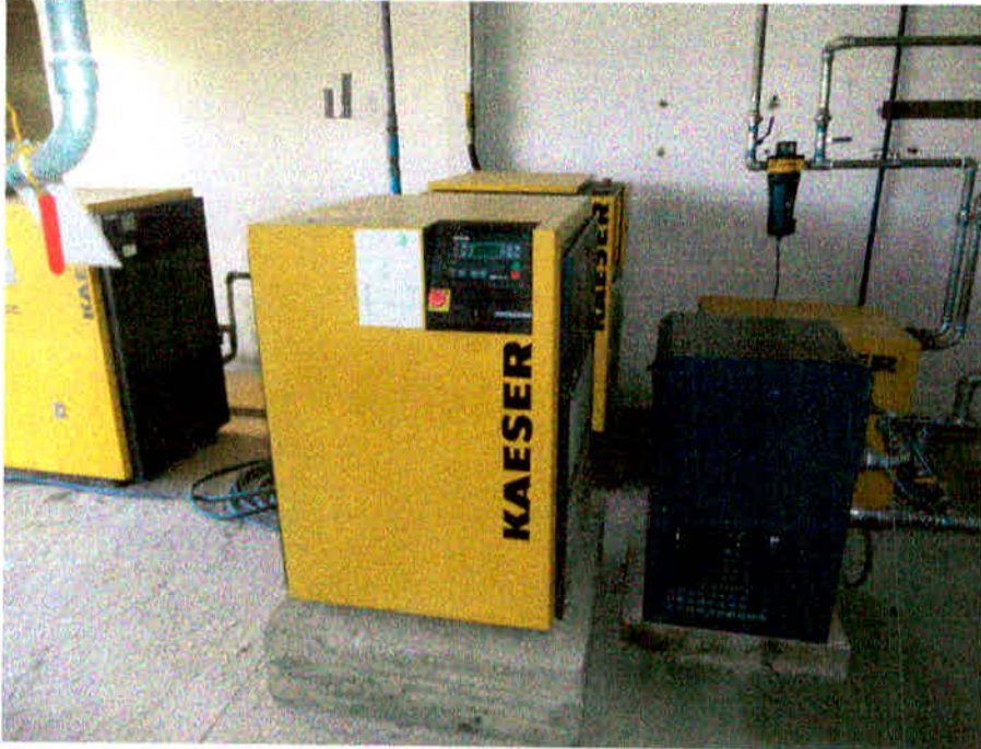
Figura 11- Compressores Kaeser
